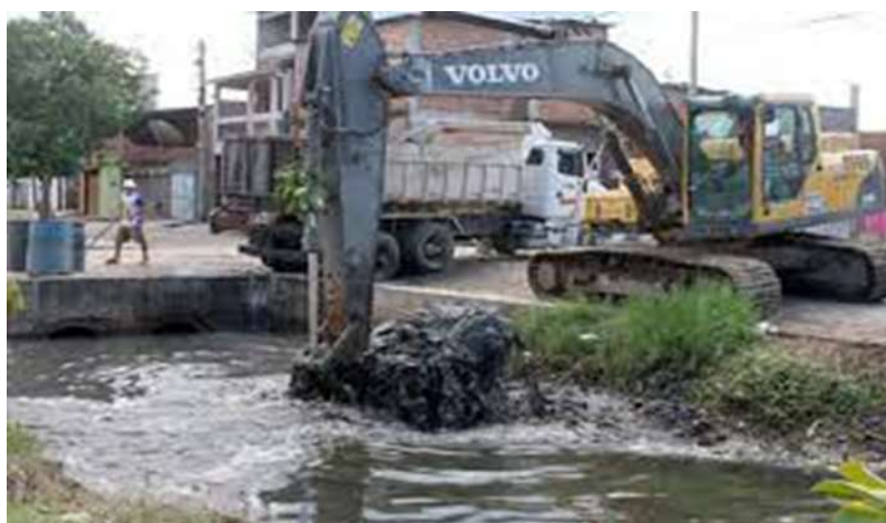
Figura 7 – Trabalho de drenagem de um rio para retirada de resíduos.
