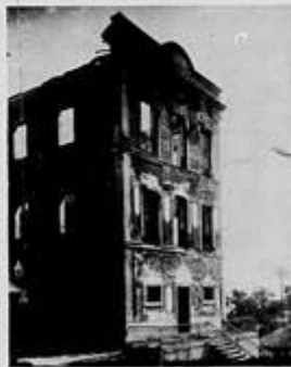
ALOJAMENTO DESTRUIDO POR UM INCÊNDIO
