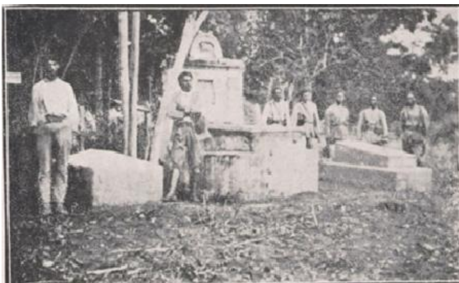
Figura 89 - Cemitério após os reparos (1926)
