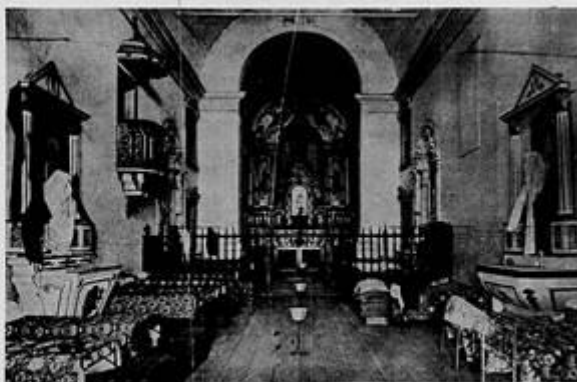
A IGREJA DE BOM JESUS TRANSFORMADA EM ALOJAMENTO
