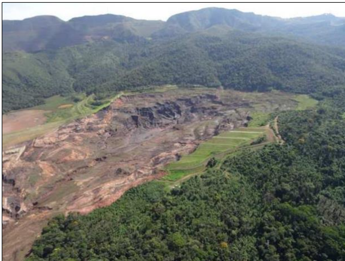
Figura 2- Vista aérea da Barragem I rompida (Robertson, 2019).
