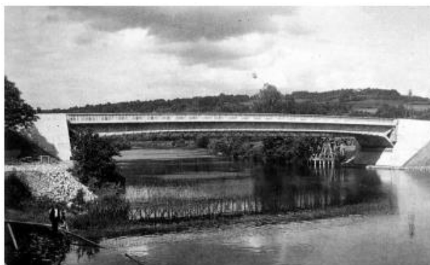
Figura 1 – Ponte de Luzancy sobre o rio Marne na França (Neto, 2016)
