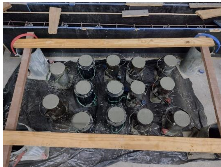
Figura 33 – Detalhe da concretagem dos corpos de prova
