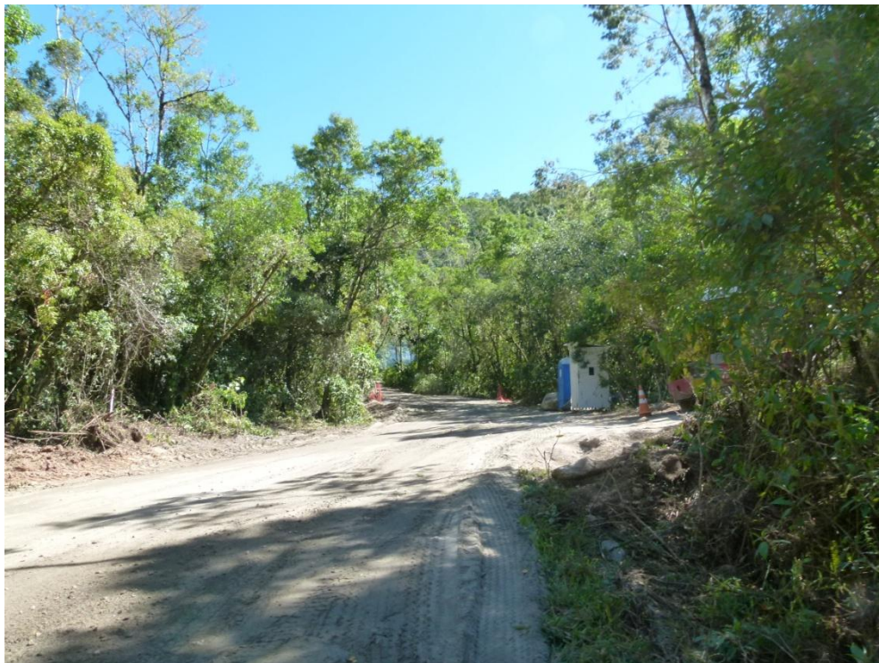
Figura 7 - Trecho da rodovia RJ-165 antes da pavimentação.
