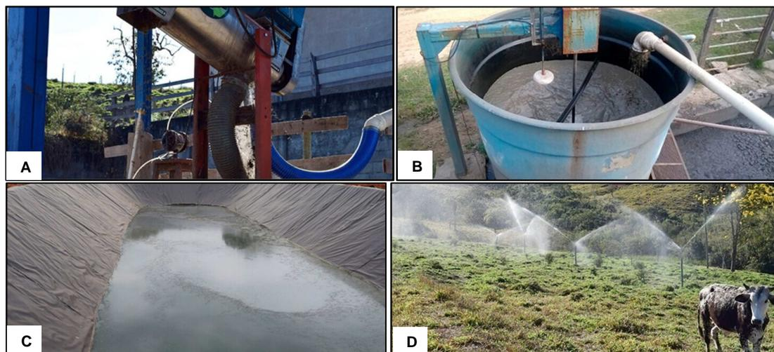
Legenda: (A) Depósito de contenção, (B) Ecco Filtro, (C) Lagoa de decantação e (D) Fertirrigação no solo.
