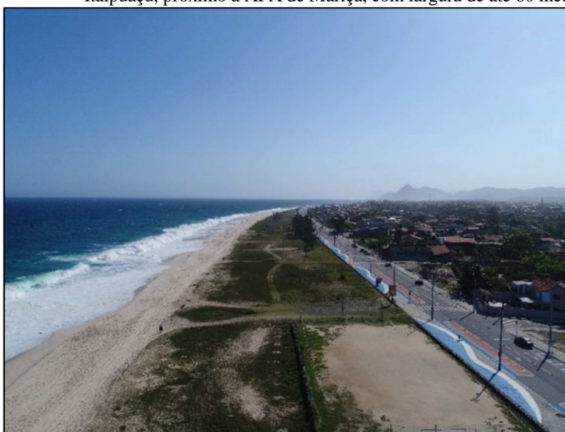
Figura 43: Presença de vegetação no pós praia no extremo leste da Orla de Itaipuaçu, próximo a APA de Mariça, com largura de até 60 metros.
