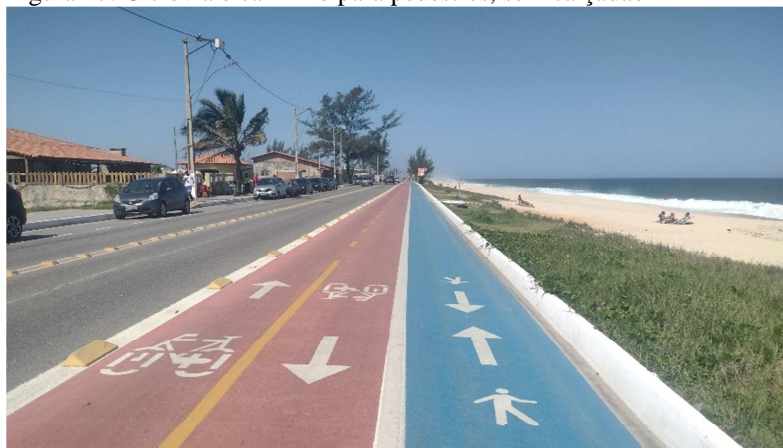
Figura 47: Ciclovia e caminho para pedestres, sem calçamento
