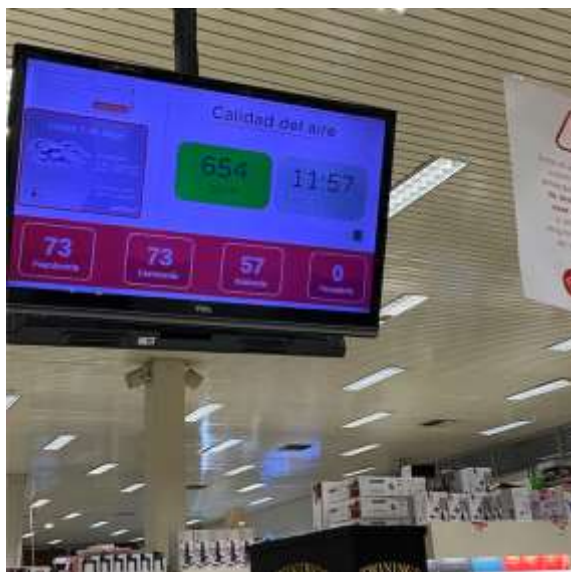
Figura 48 – Tela de monitoramento da qualidade do ar em supermercado
