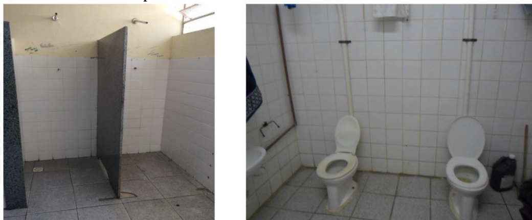
Figura 22 - Cabines desprovidas de portas, chuveiros e divisórias - Centro Municipal Roberto Silveira e Escola Guandur Assed
