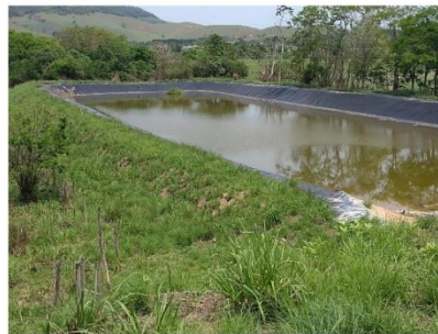
Figura 2- Aterro sanitário inacabado no município de Tanguá/RJ
