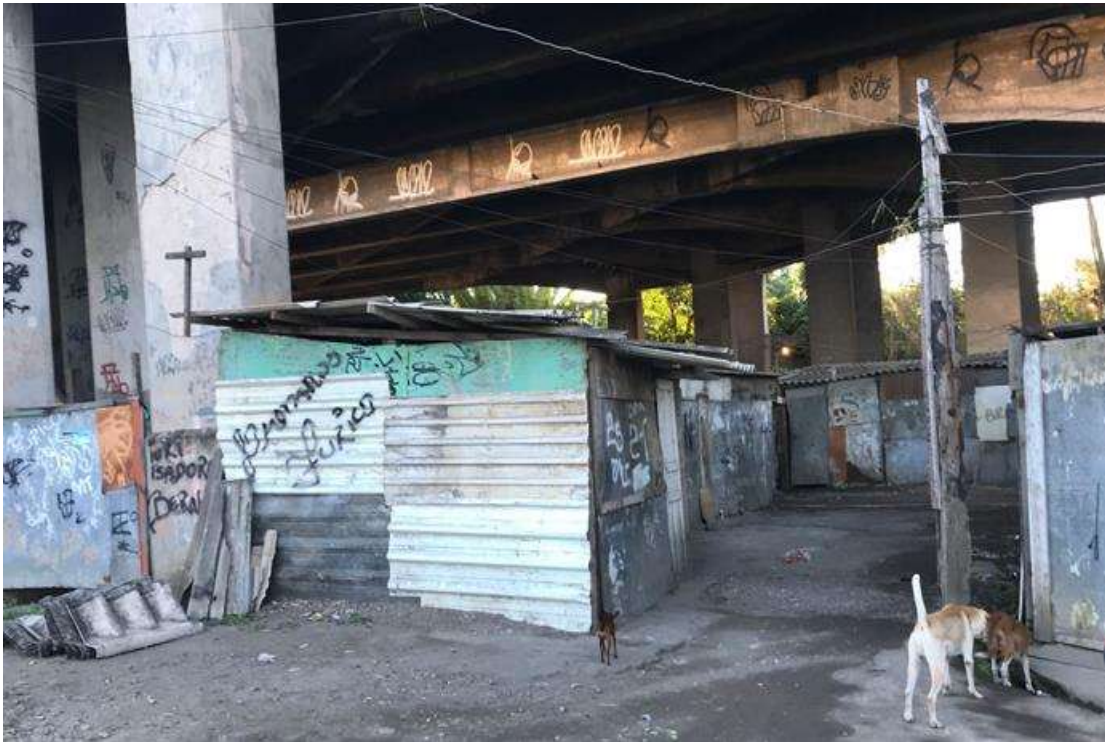
Figura 03 - Fotografia da “ponte
