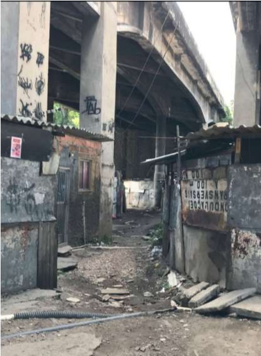
Figura 02 - Fotografia da “ponte”
