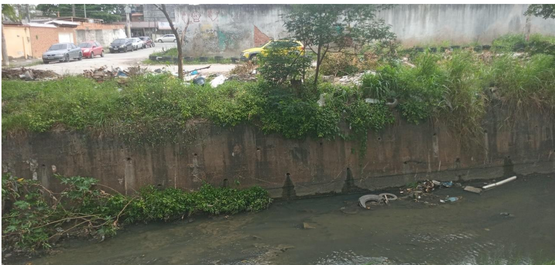
Figura 35: Local utilizado para despejo de entulho nas margens, além de muitos objetos dentro do rio como pneus e canos
