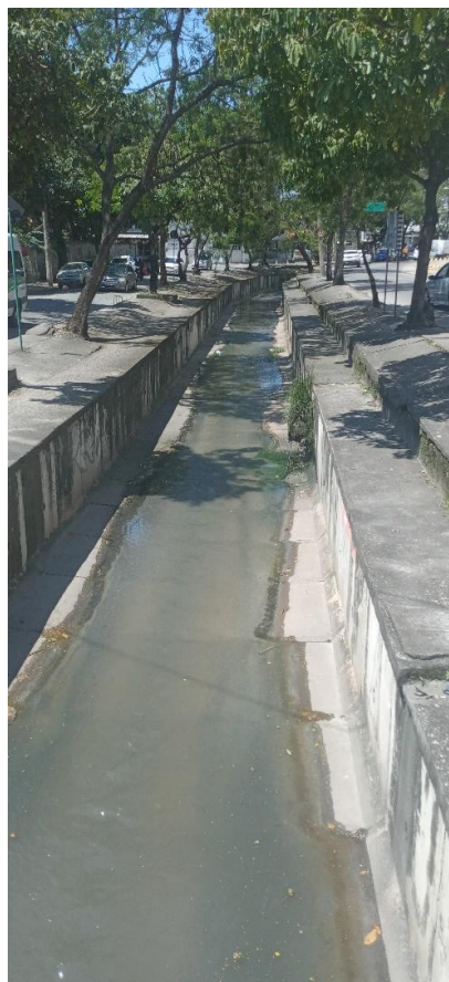
Figura 32: Canal do Melo canalizado
