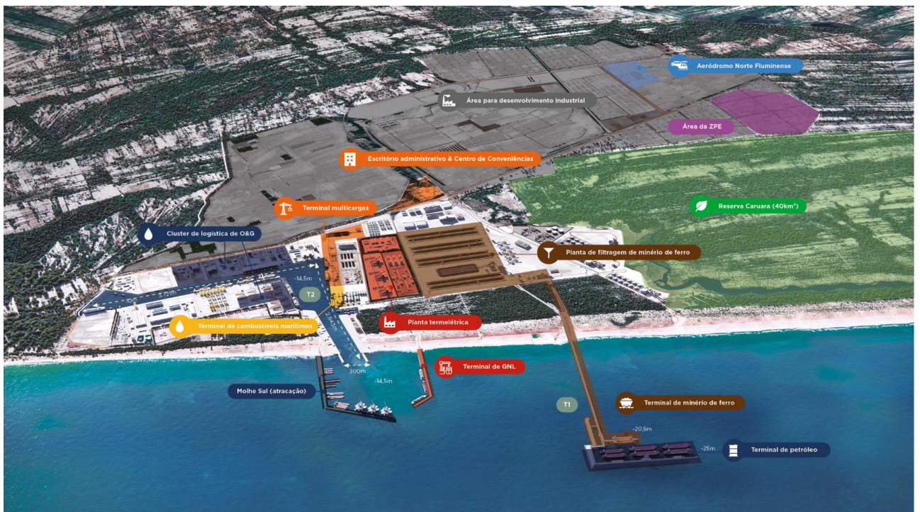
Figura 41 - Infraestrutura do Porto do Açu (PRUMO, 2022).
