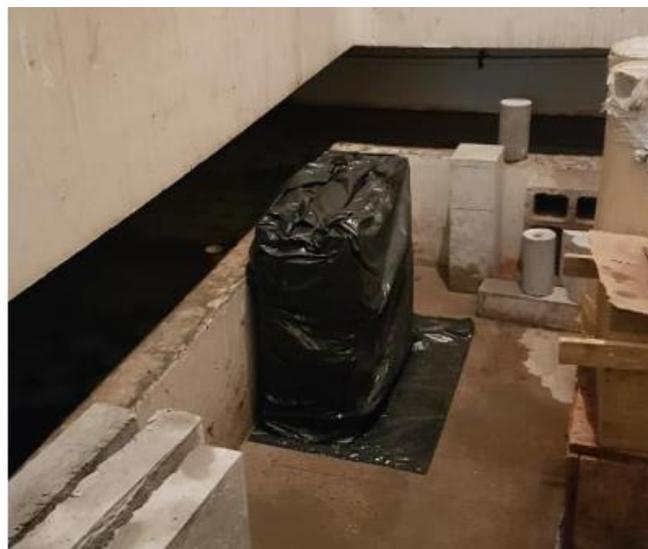
Figura 34 – Cura úmida das placas de concreto
