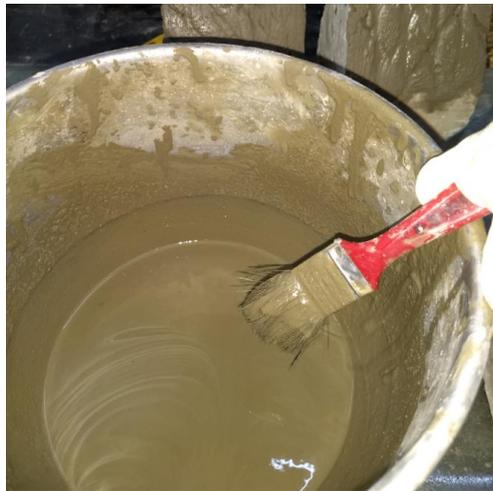
Figura 42- Consistência da ponte de aderência
