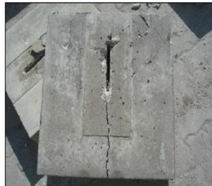
b) Cisalhamento do concreto
