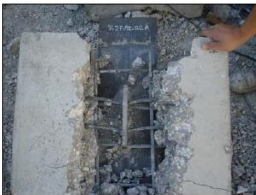
a) Plastificação da armadura
