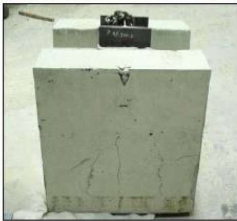
a) Fissuras no concreto
