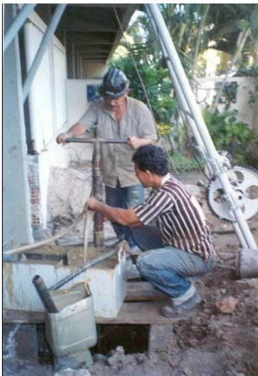
Figura 35. Sondagem junto às fundações, externamente ao edifício, (Rosa, 2005).
