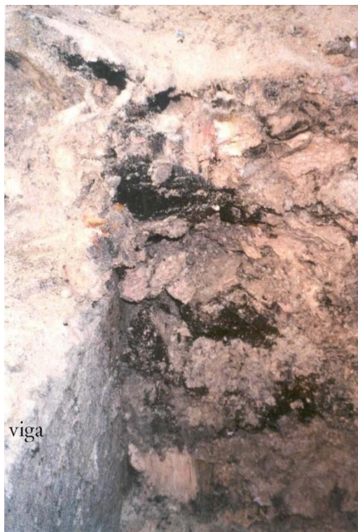
Figura 36. Reaterro junto a uma viga, com presença de turfa, (Rosa, 2005).
