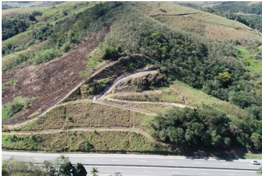
Figura 19 – Vista geral do Talude (Imagens de drone - 2020)
