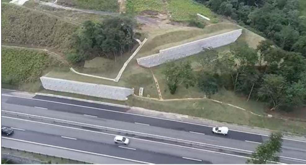
Figura 20 - Vista geral do Talude após as intervenções de 2021 (Imagens de drone)
