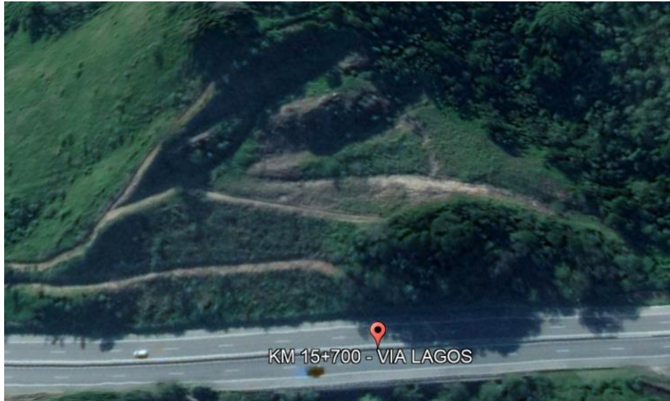
Figura 18 - Localização do Talude (Google Earth - 2018)
