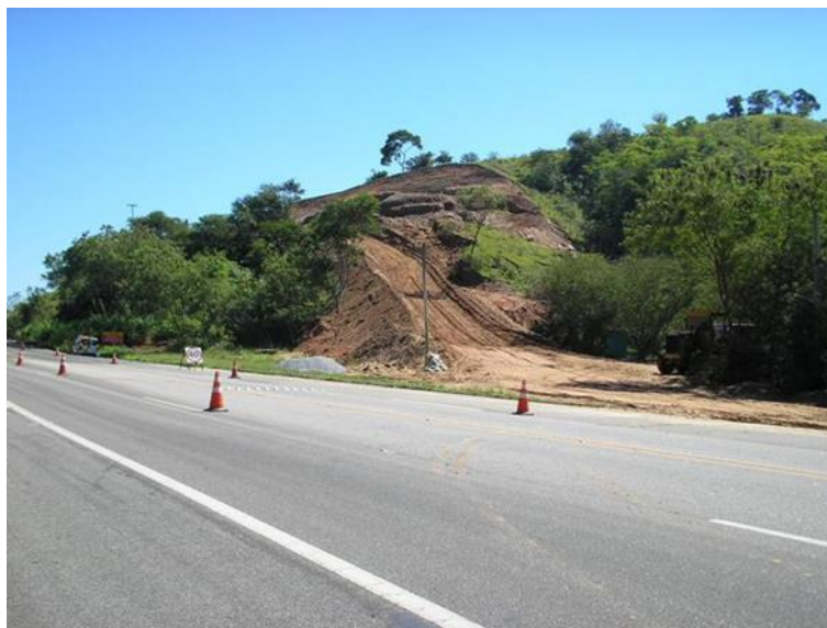
Figura 16 - Etapa de execução da 1ª fase de terraplenagem (CCR - 2006)
