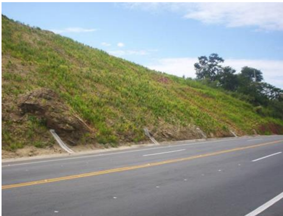
Figura 17 – Instalação de 11 DHP's no pé do talude (CCR - 2007)
