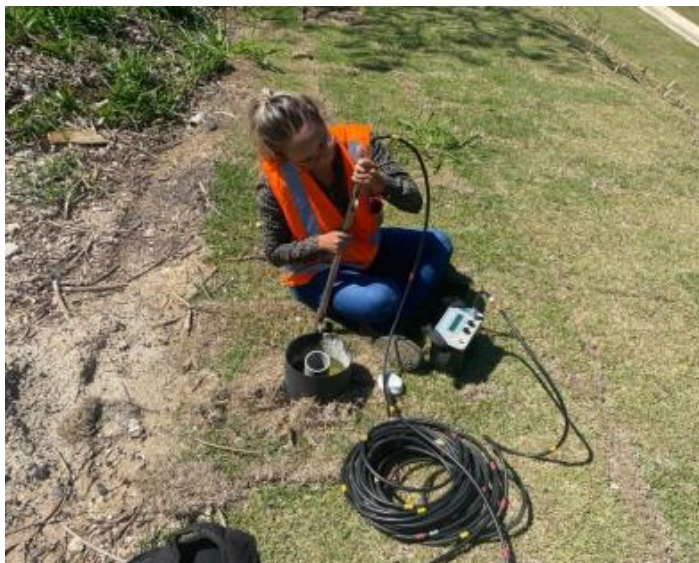
Figura 7 – Leitura de Inclinação no talude do Km 15+700 (FGEO, 2021)
