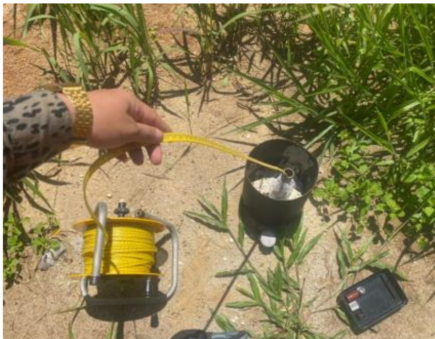
Figura 10 – Leitura de Indicador de Nível d'água no talude do Km 15+700 (FGEO, 2021)
