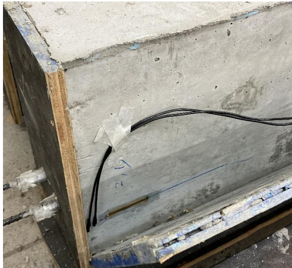
Figura 68 – Extensômetro adicionado ao concreto na altura das barras protendidas
