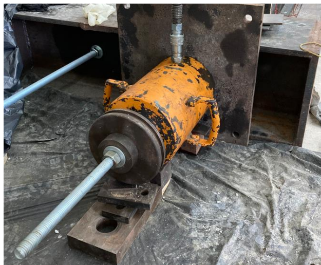
Figura 50 - Execução da protensão na 1ª viga e visualização da porca em aço na barra roscada a esquerda da imagem
