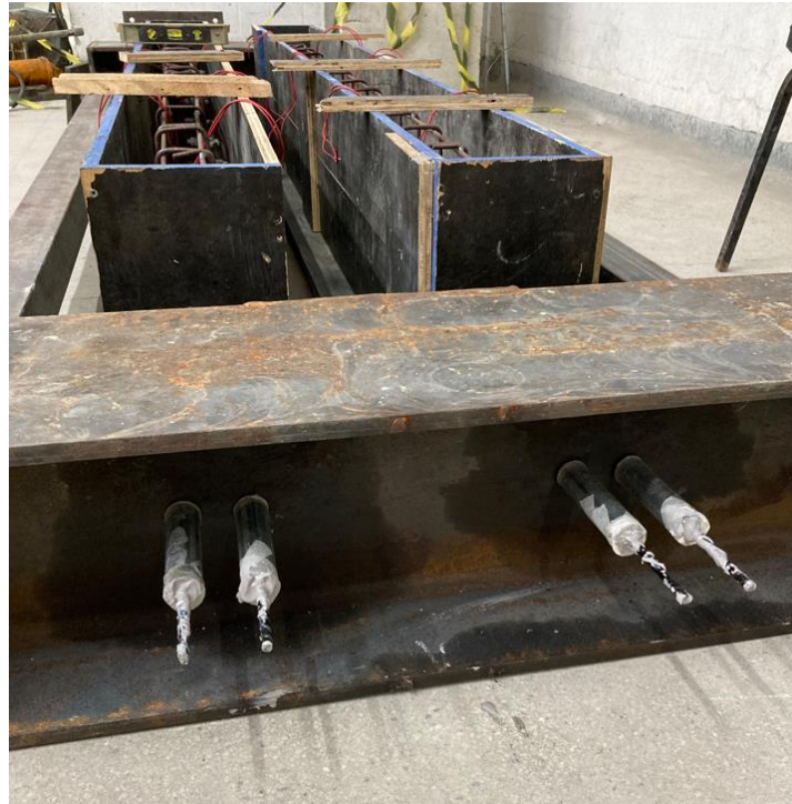
Figura 48 - Ancoragem fixada no pórtico de reação
