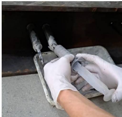
Figura 47 - Preparo da ancoragem com tubos redondos vazados e Sikadur 32
