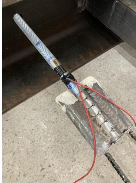
Figura 46 - Estrutura em aço montada para a protensão das barras em conjunto
