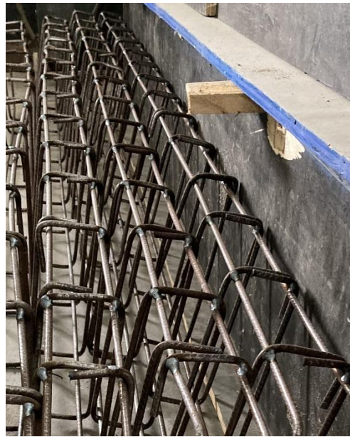
Figura 33 – Armaduras passivas e estribos montados
