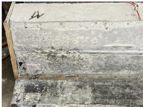
Figura 69 – Viga 2 após a ruptura das barras de BFRP
