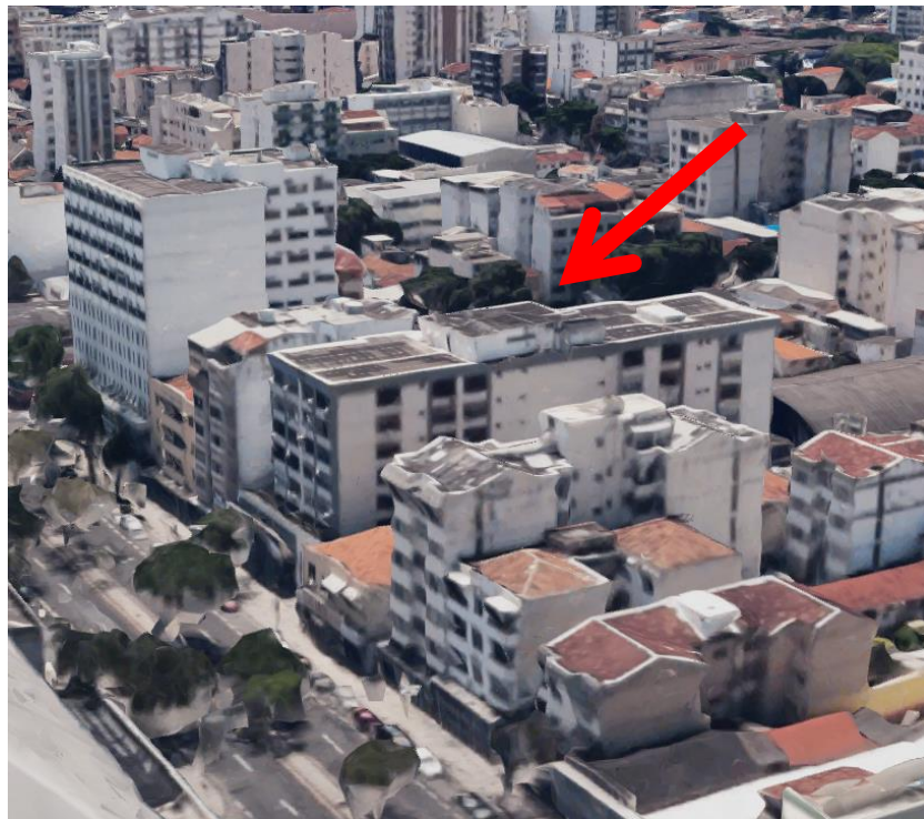
Figura 24 – Edifício onde foi realizada a monitoração.
