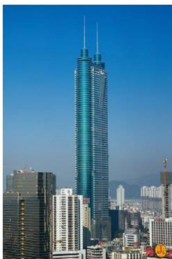
a) Di Wang Tower
