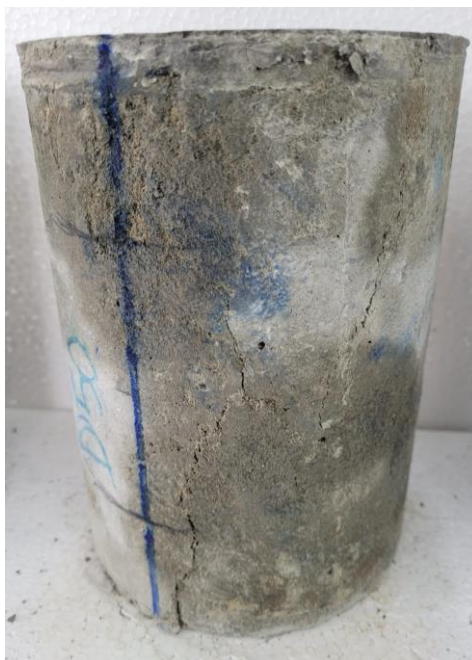
Figura 130 - Padrão de fissuração após o ensaio de compressão aos 28 dias do CP08 reparado, com dano 50% (C1-D50) camada de 2,20 cm do reparo.
