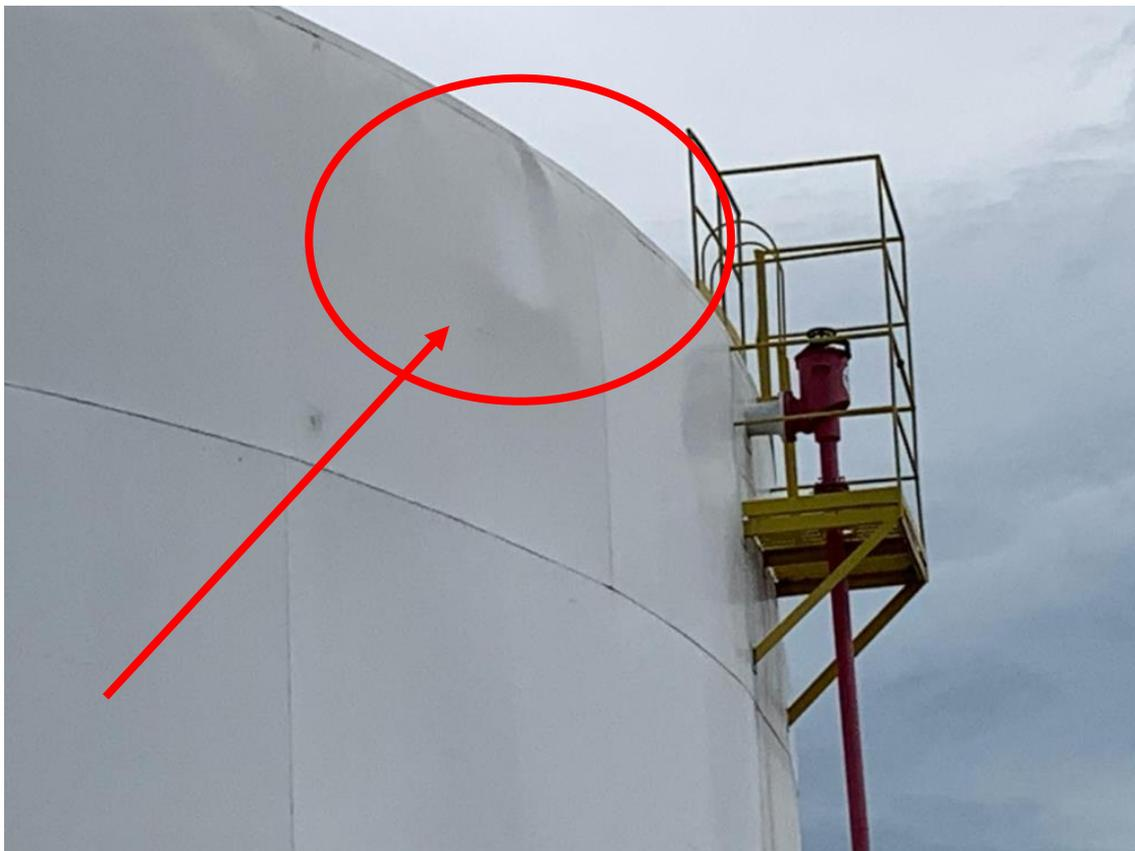
Figura 5 – Exemplo de imperfeição estrutural em tanques (Imagem do autor).
