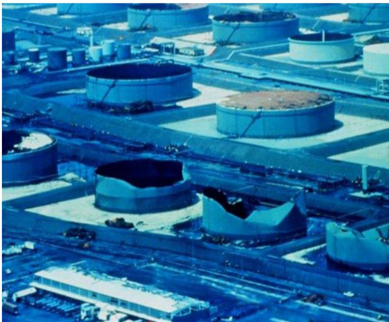
Figura 7 - Exemplo de flambagem de tanques reais [5]
