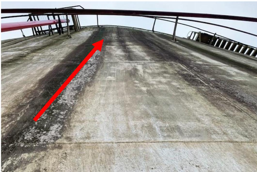
Figura 25 - Detalhe das deformações no costado (Imagem do autor).
