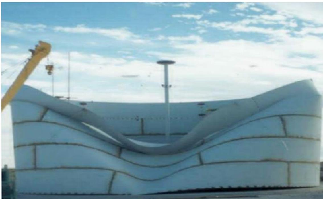
Figura 4 – Flambagem de tanque durante construção [1]
