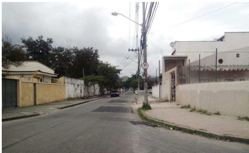
Figura 19 - Características urbanísticas da microrregião em estudo: predominância residencial, com edificações de um a dois andares e vias com duas faixas de rolamento. Foto obtida em junho de 2013
