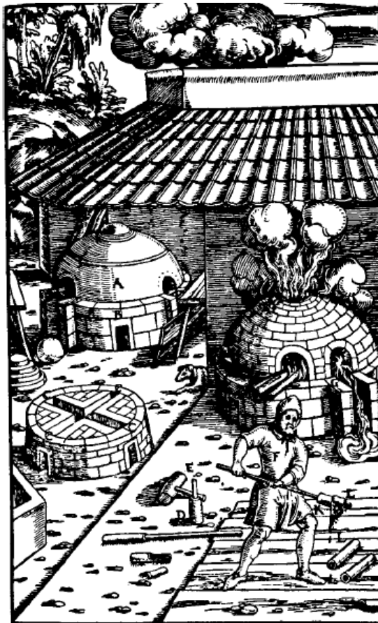
Figura 1 - Forno de fundição de chumbo no Século XVII
