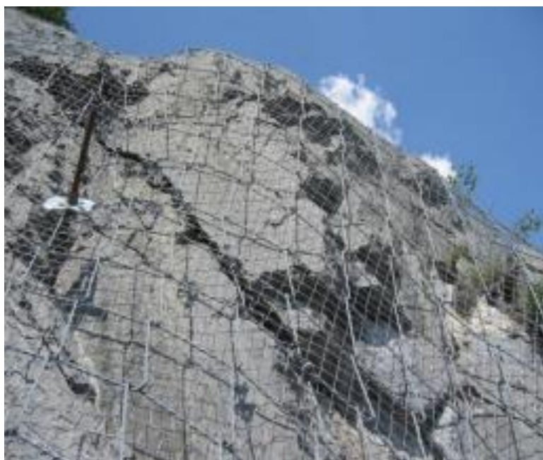
Figura 24 – Estabilização por telas metálicas e chumbadores (Geobruigg, 2012 apud Gálvez, 2012).
