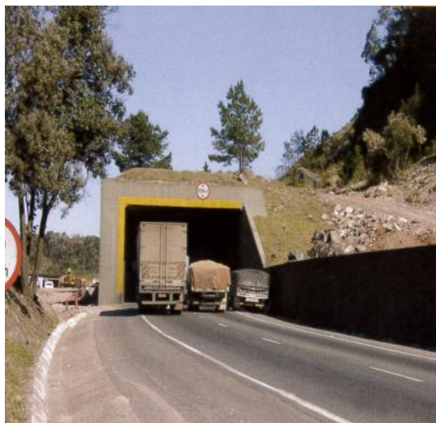
Figura 26 – Falso túnel empregado na rodovia BR-277 junto a área susceptível a queda de blocos (GEO-RIO, 2014).
