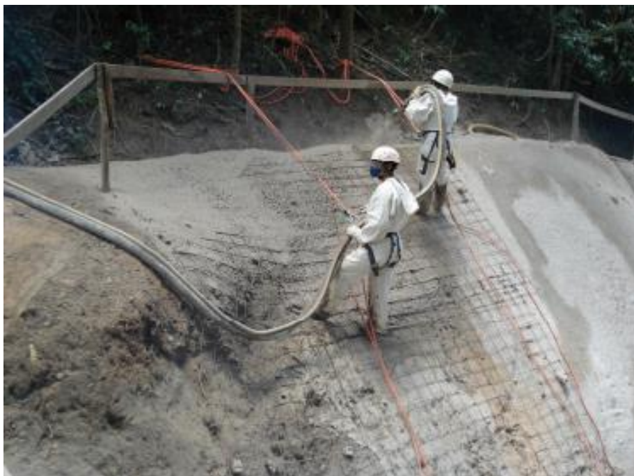
Figura 22 – Aplicação do concreto projetado (Rocha, 2009).
