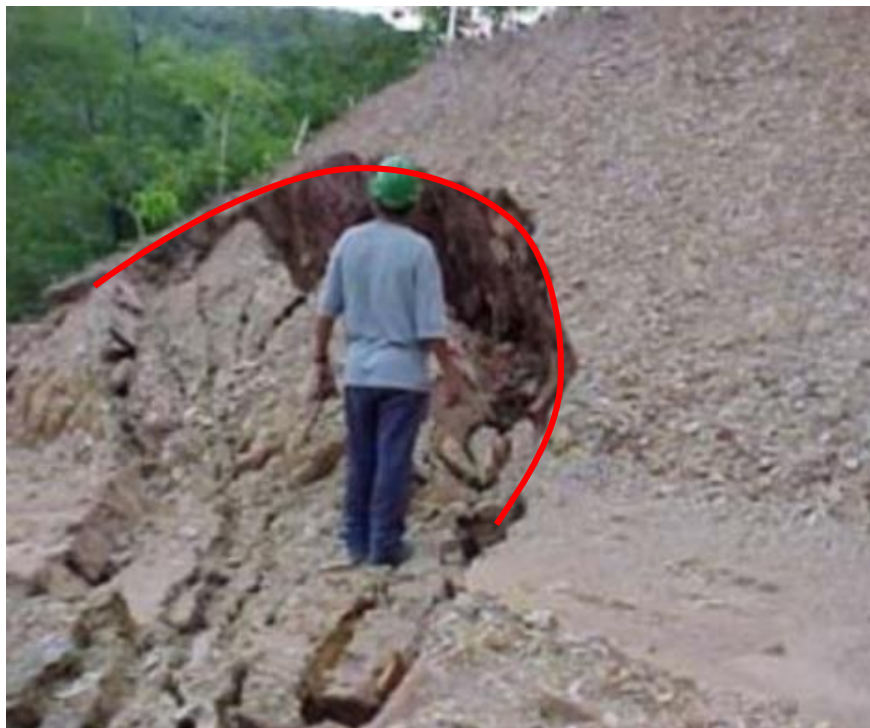
Figura 10 – Ruptura Circular em maciço de ardósia muito alterado (Nunes, 2008 apud Villela, 2011).
