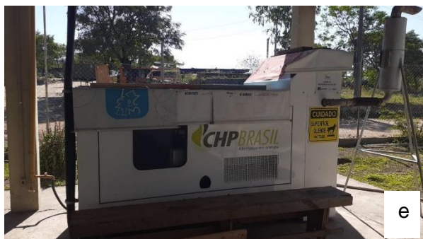
a) Pátio de recepção e preparo do substrato; b) Reator MESB; c) Unidade de produção de inóculo (UPI); d) ■ Biofiltro/ ■ Queimador fechado de biogás; e) Cogenerador de energia térmica e elétrica (CHP); f) Amostra do material digerido.
