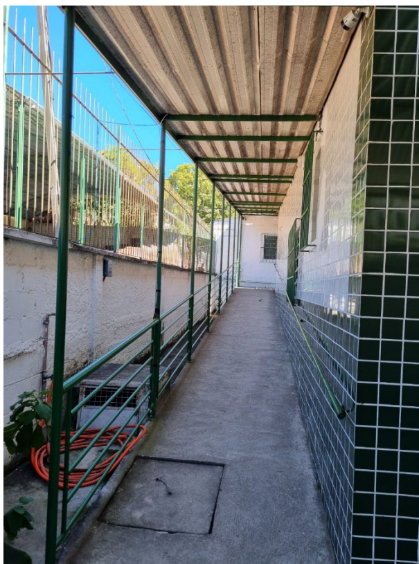
Figura 20 - Ponte de acesso aos anexos da Escola Sebastião Branco
