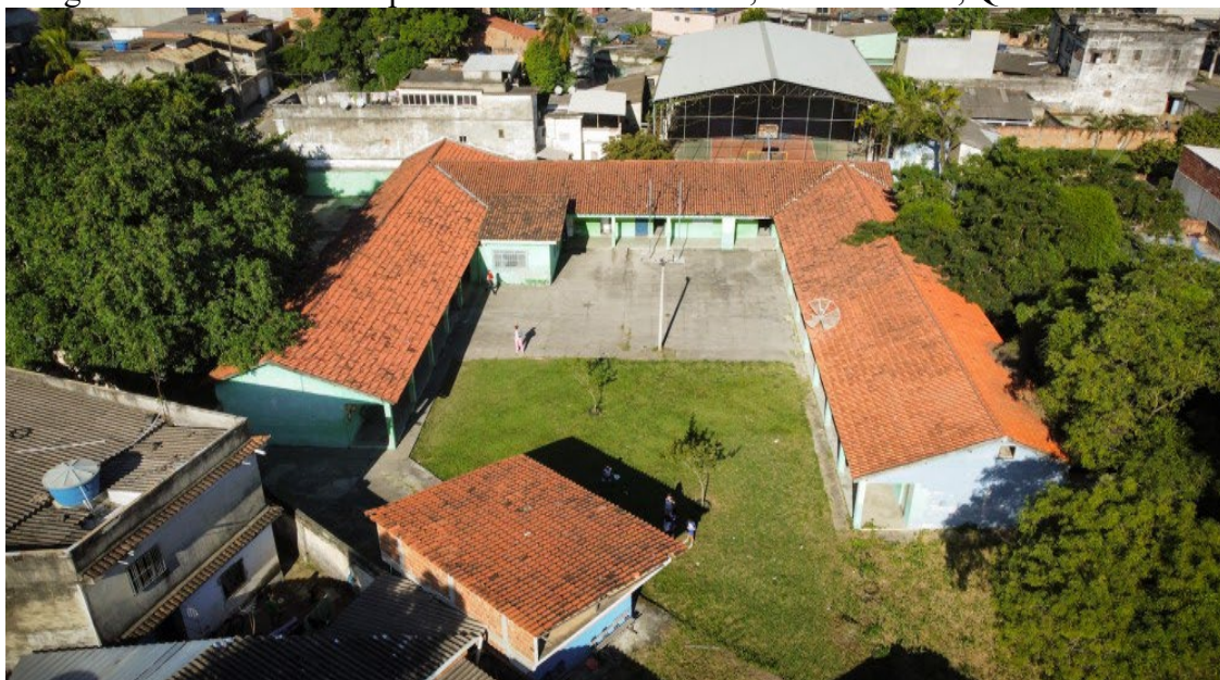
Figura 4 – Escola Municipalizada José de Anchieta, Jardim Alzira, Queimados - RJ
