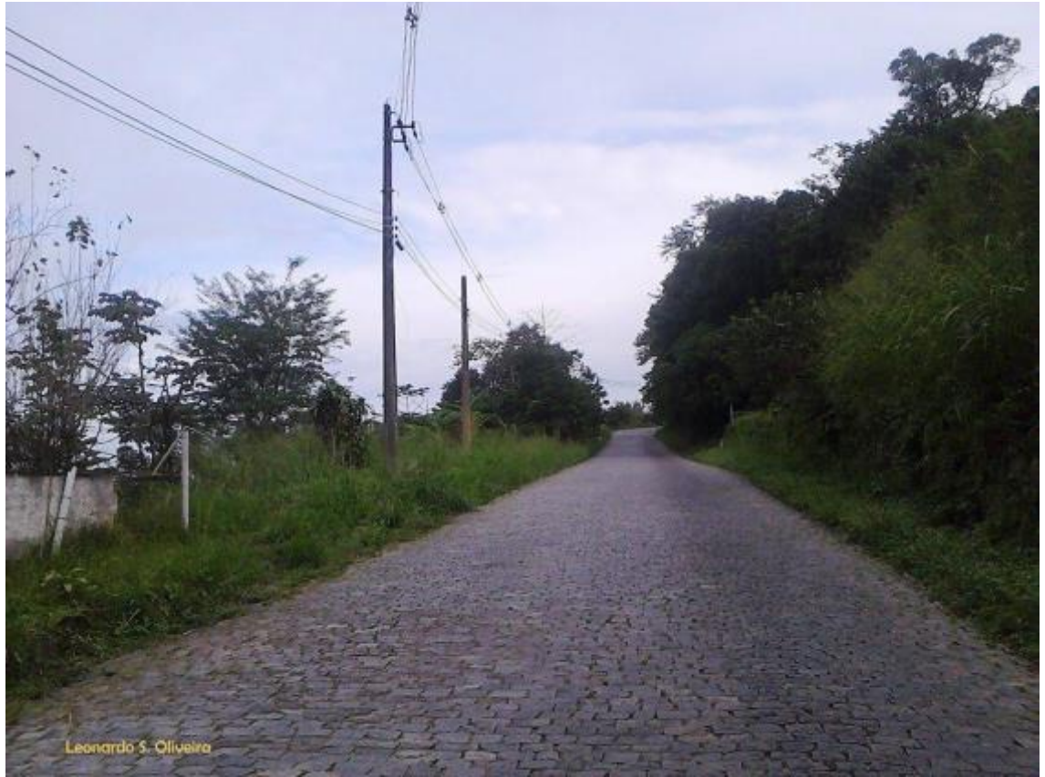
Figura 15 - Estrada Velha da Estrela no bairro Meio da Serra
