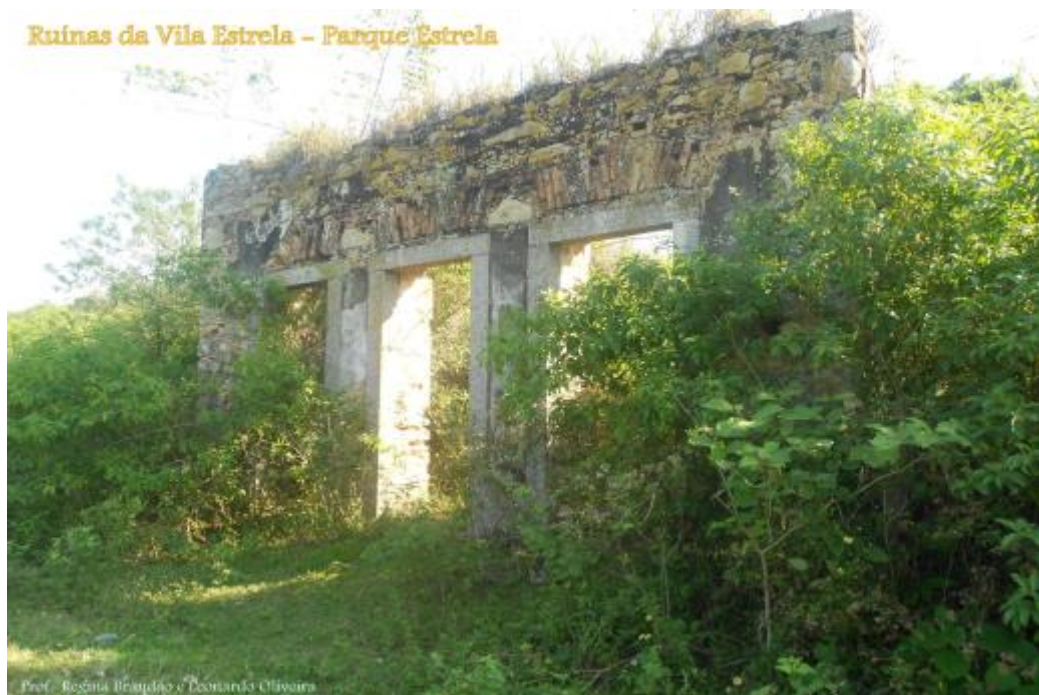
Figura 23 - Ruínas da Vila Estrela H (Parque Estrela)
