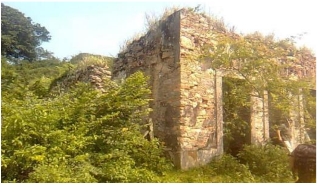
Figura 21 - Ruínas da Vila Estrela F
