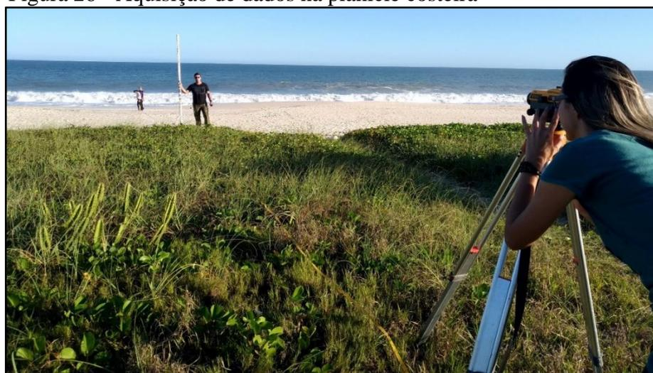
Legenda: Aquisição feita com o nível topográfico.
