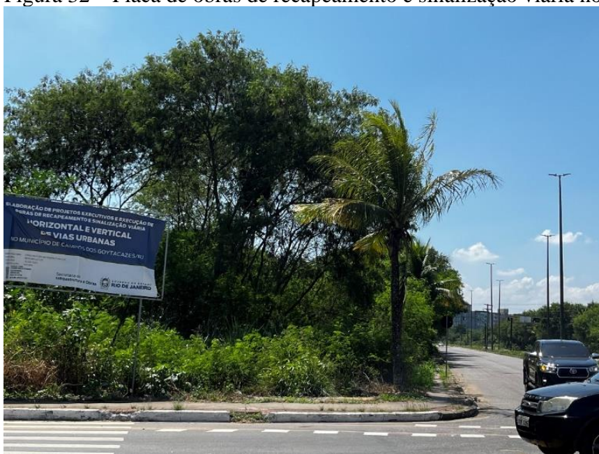
Figura 32 – Placa de obras de recapeamento e sinalização viária no Flamboyant
