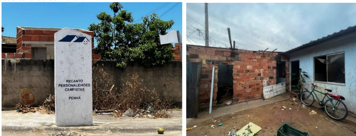
Figura 10 – Obras em unidade habitacional do “ Morar Feliz ” para ampliar a casa e para abertura de comércio
