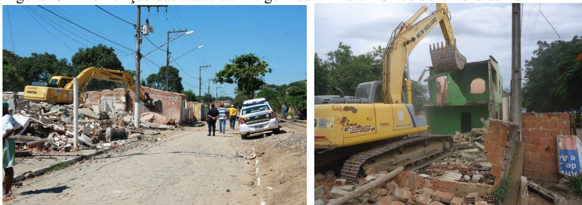
Figura 13 – Demolição das casas da Margem da Linha em 02 de dezembro de 2014
