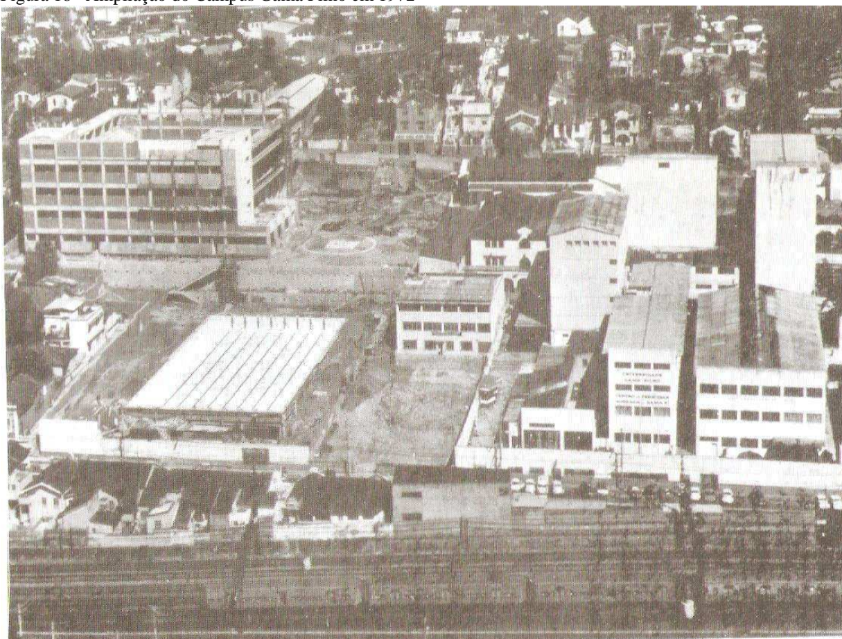
Figura 18 - Ampliação do Campus Gama Filho em 1972
