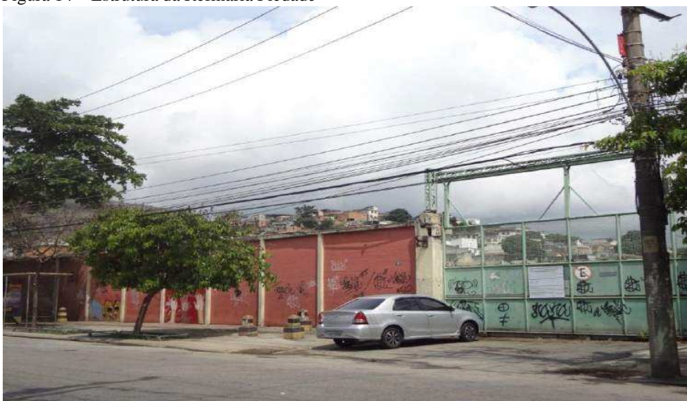
Figura 14 – Estrutura da Refinaria Piedade
