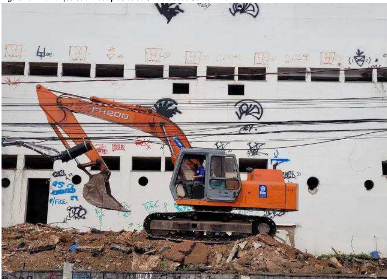
Figura 47 - Demolição de um dos prédios da Universidade Gama Filho
