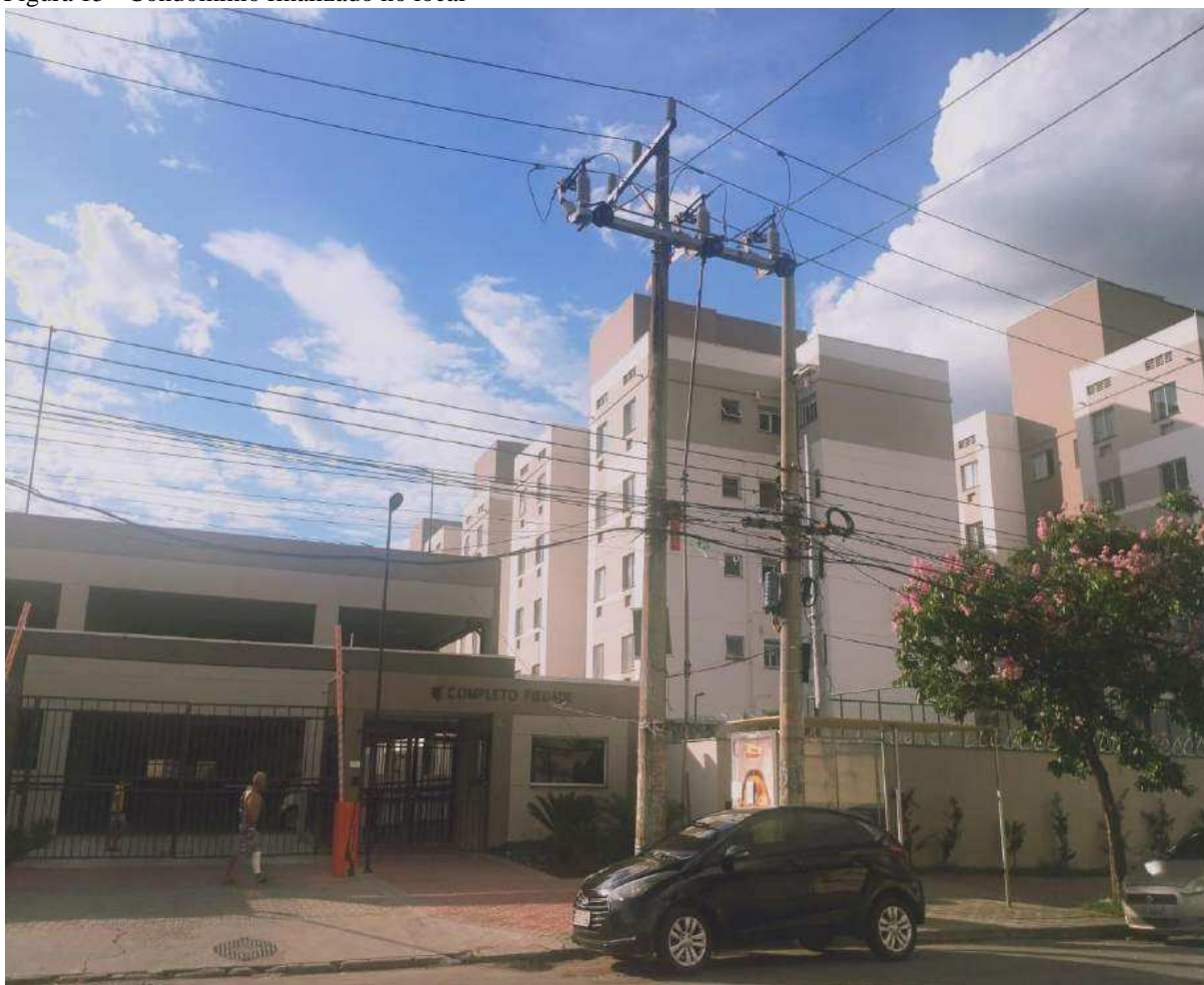
Figura 15 - Condomínio finalizado no local
