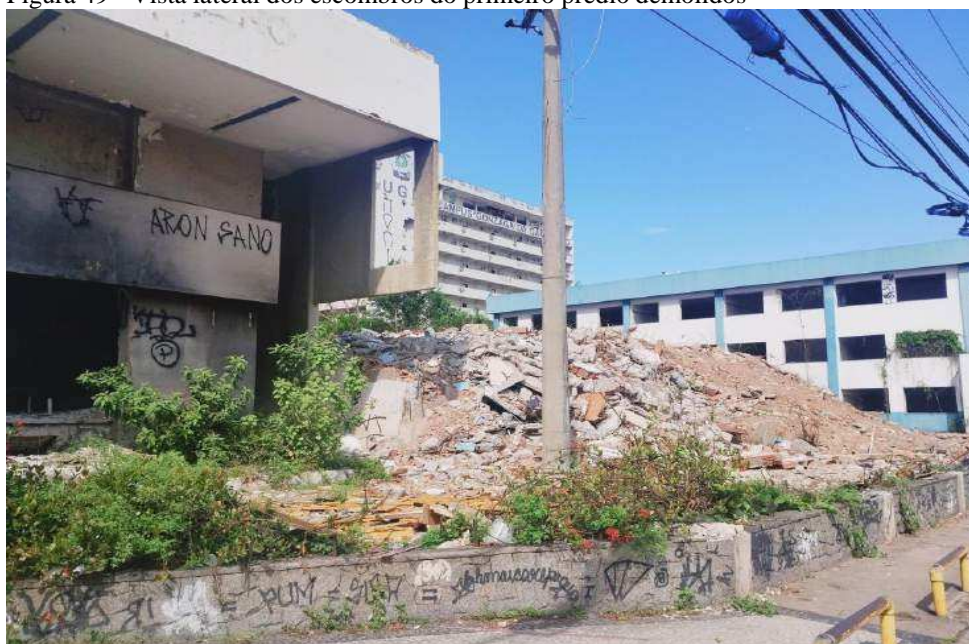
Figura 49 - Vista lateral dos escombros do primeiro prédio demolidos
