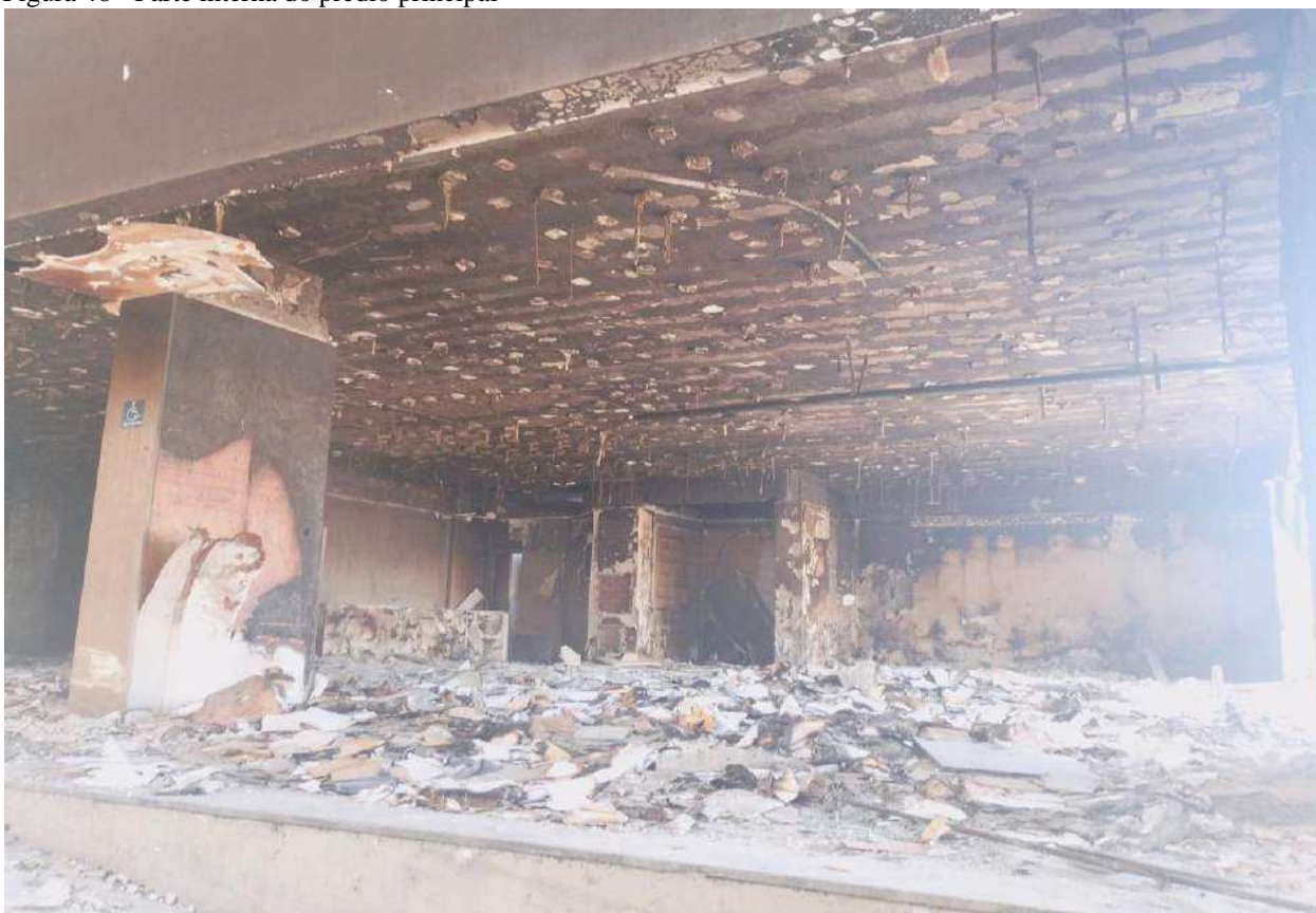
Figura 46 - Parte interna do prédio principal
