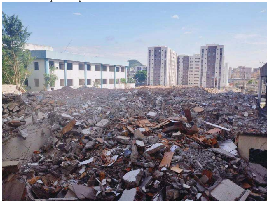
Figura 48 – Escombros do primeiro prédio demolido
