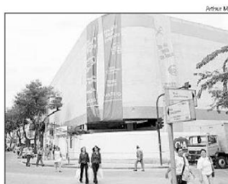
AS OBRAS DO PASSEIO Shopping já estão na fase de acabamento
