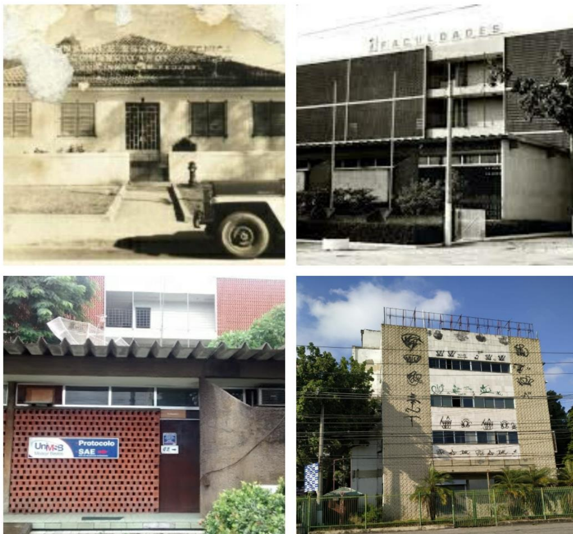
Figura 36 - Colégio Afonso Celso em seu antigo endereço na Rua Coronel Agostinho, Faculdades Integradas Moacyr Sreder Bastos, Centro Universitário Moacyr Sreder Bastos, prédio abandonado do Colégio Afonso Celso
