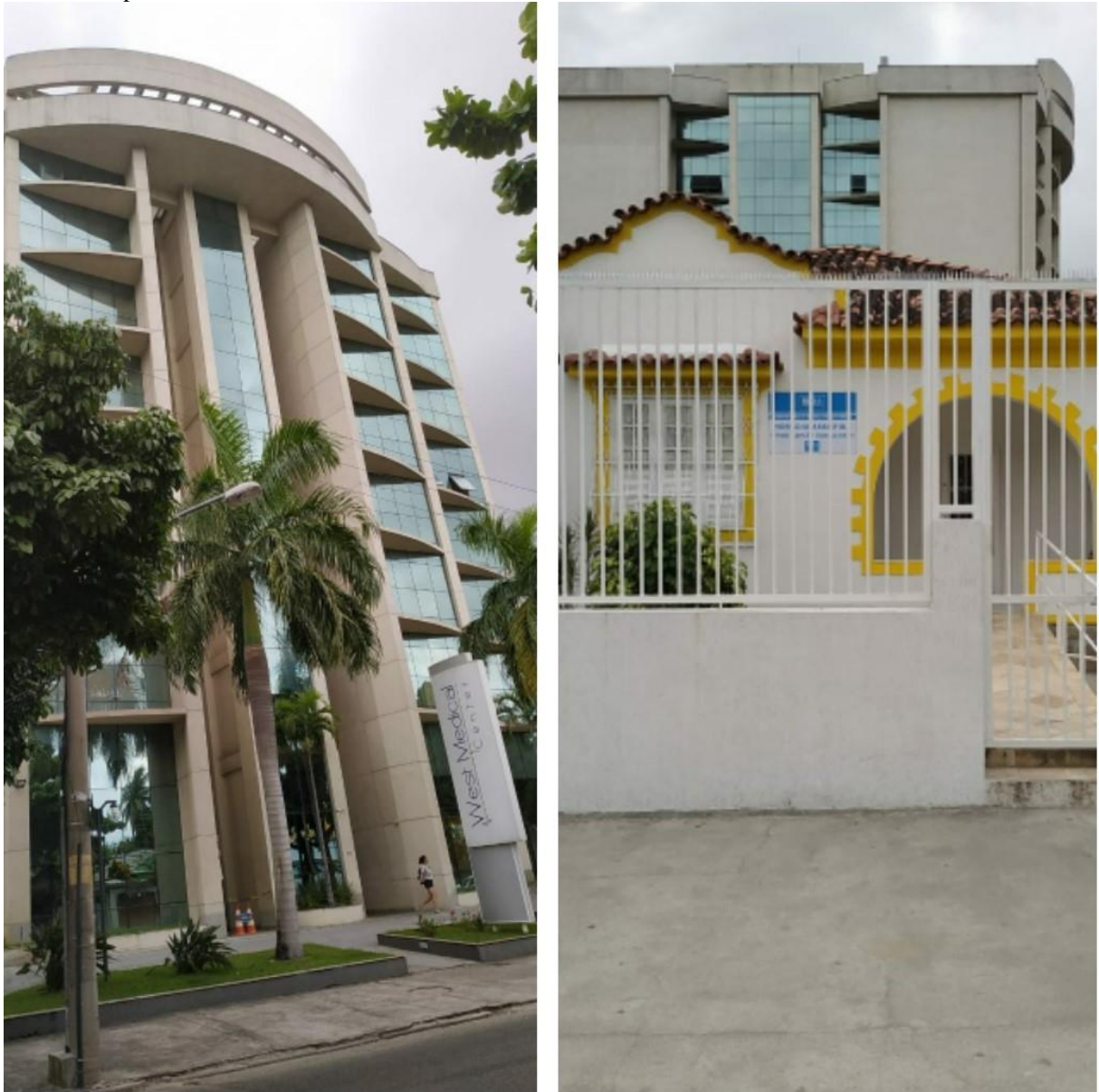
Figura 18 - Fachada do West Medical Center na rua Ivo do Prado e casas na testada da Rua Campo Grande com o prédio West Medical Center ao fundo
