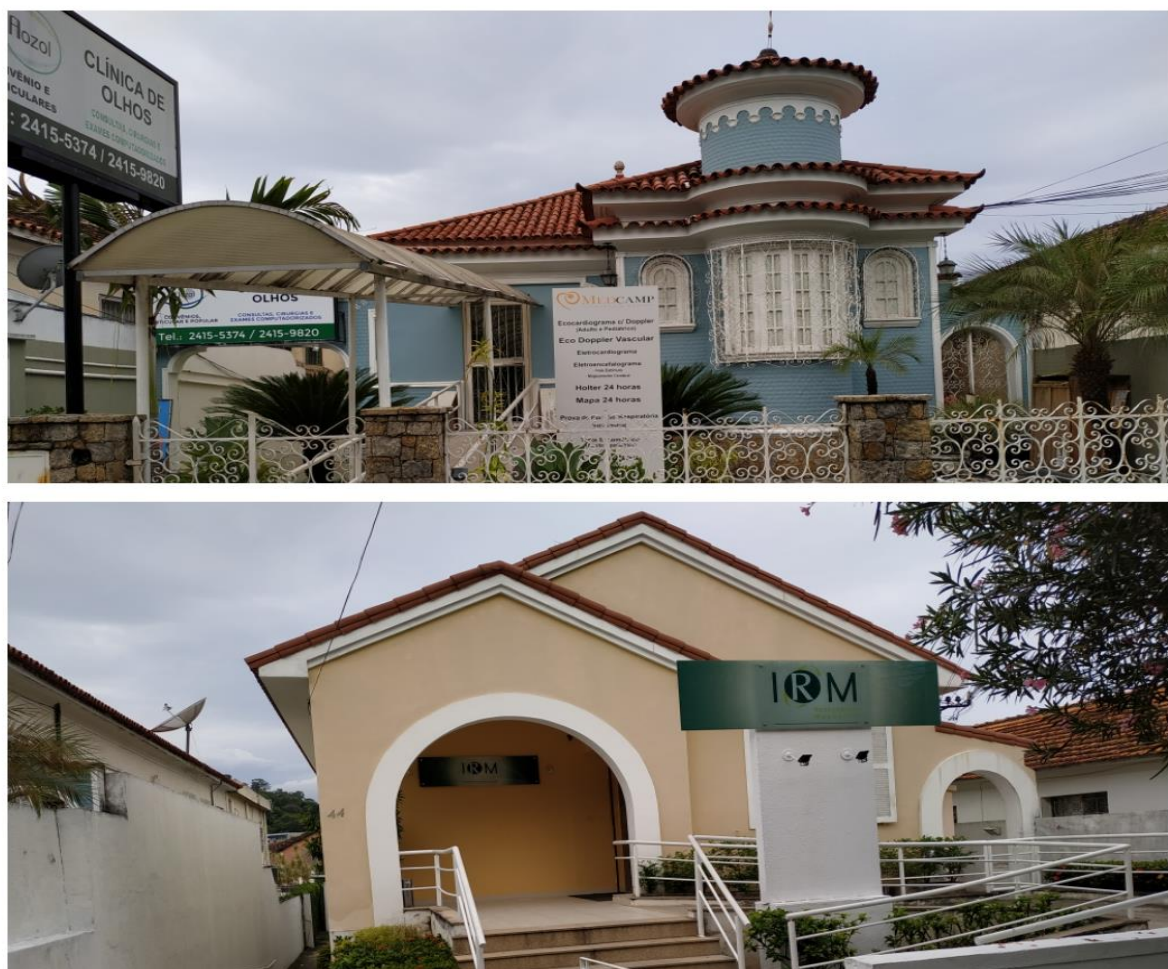
Figura 15 - Casario refuncionalizado para serviços médicos-hospitalares especializados na Rua Jaguaruna – Campo Grande, Rio de Janeiro
