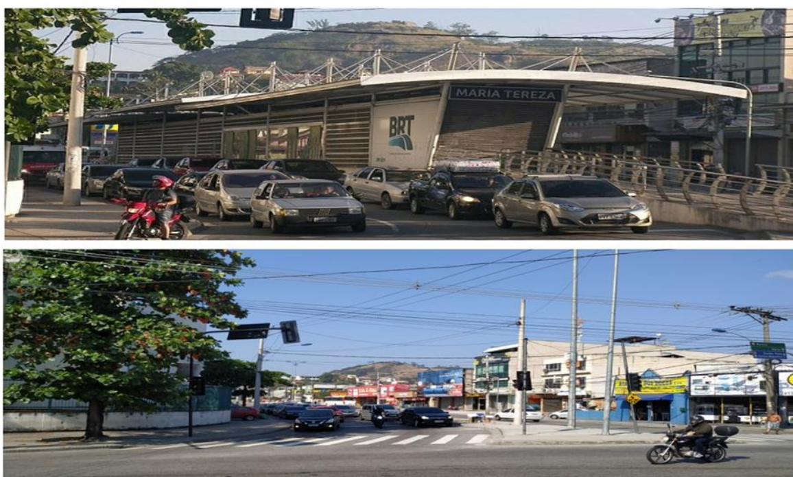
Figura 1 - Estação Maria Tereza no cruzamento da Avenida Madre Teresa, Avenida Cesário de Melo e Estrada do Monteiro
