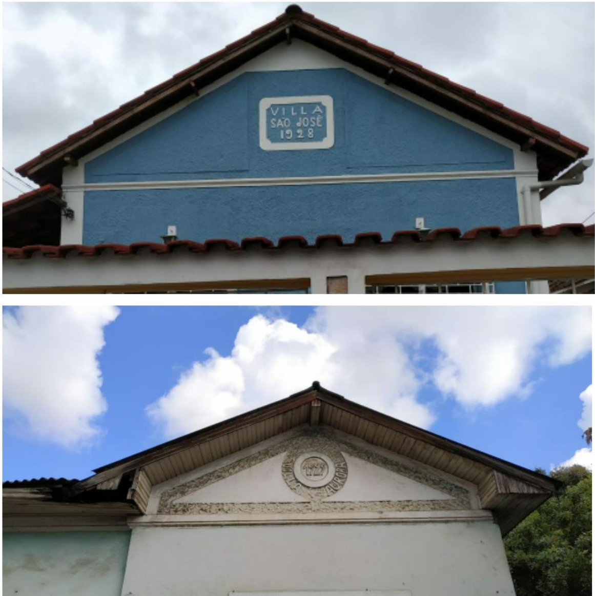
Figura 16 - Casa azul da Villa São José, datada de 1928, na Rua Vítor Alves e casa verde da Villa Aurora, datada de 1929, na Rua Barcelos Domingos, Campo Grande – Rio de Janeiro
