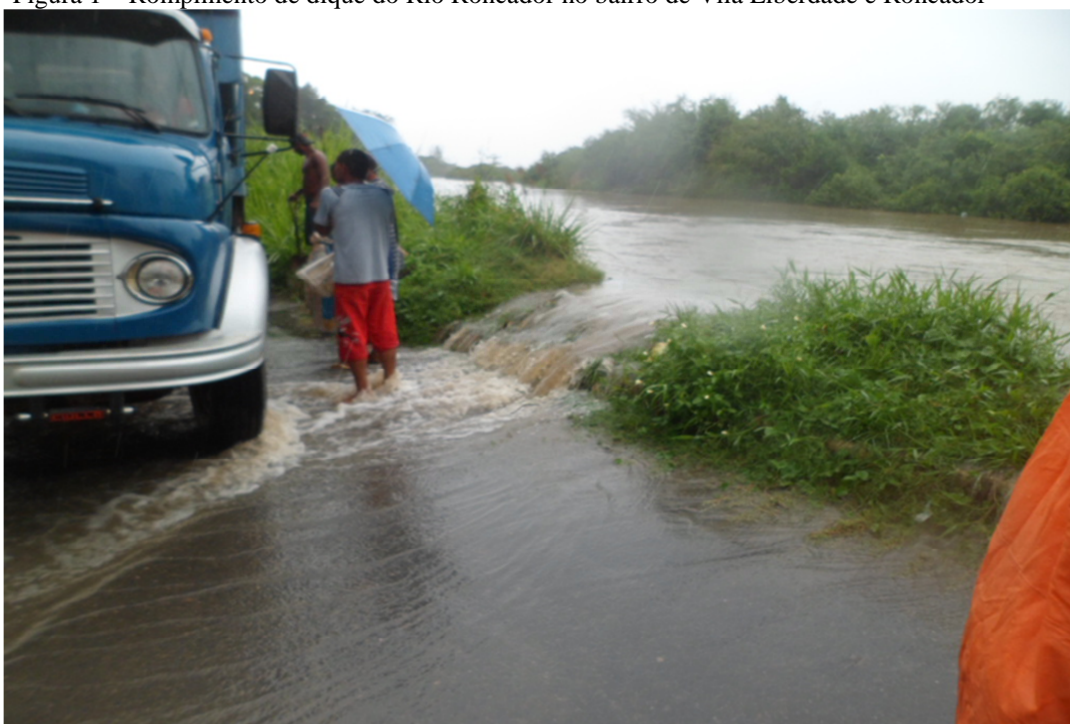
Figura 1 – Rompimento de dique do Rio Roncador no bairro de Vila Liberdade e Roncador
