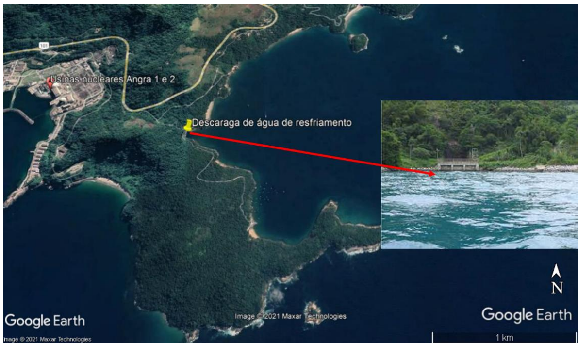
Figura 18. Local de descarga de água de resfriamento, Piraquara de Fora, Angra dos Reis.
