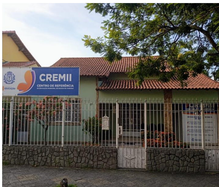
Figura 5: Prédio do CREMII
