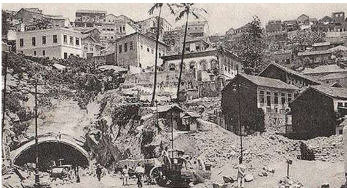
Figura 7: Início das obras do túnel João Ricardo no local onde existia o Cortiço Cabeça de Porco 165
