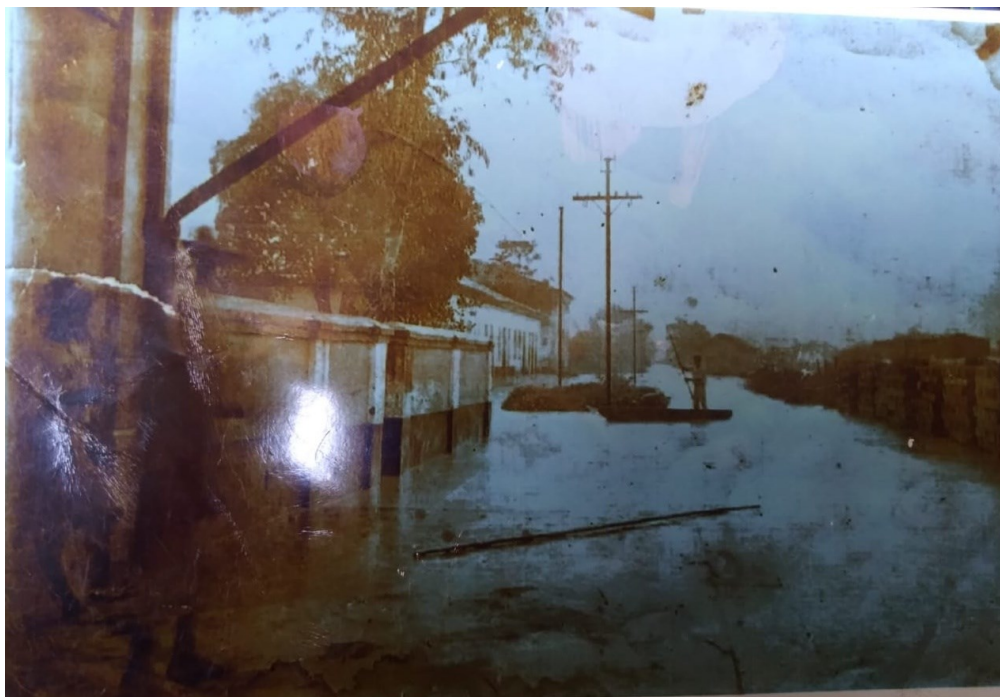
Figura 3 - Avenida Central em Sant'Anna de Japuíba alagada pelas cheias do rio Macacu
