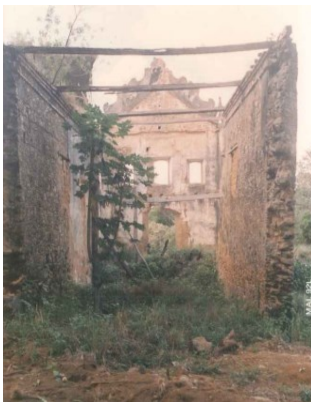
Figura 23 - Igreja São José do Queimado–vista interna (1992)
