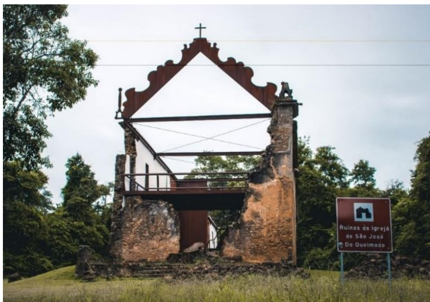
Figura 14 - Ruínas da Igreja São José do Queimado
