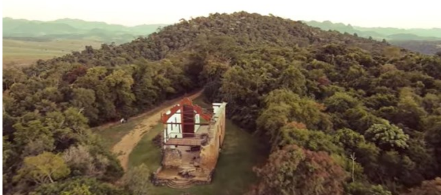
Figura 26 - Vista de cima das ruínas da igreja de S. José do Queimado
