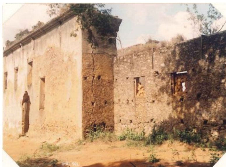
Figura 24 - Igreja São José do Queimado – Fachada Frontal (1992)
