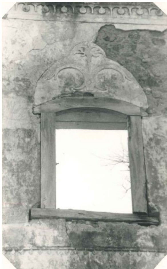
Figura 22 - Igreja São José do Queimado – Janela frontal esquerda-vista externa (1992)
