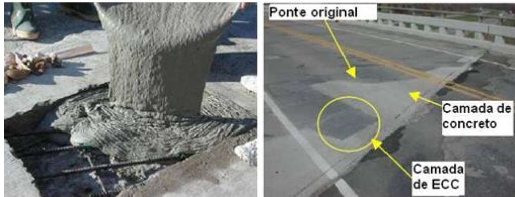
Figura 7 - Reparo do tabuleiro de uma ponte em Michigan, Estados Unidos, utilizando-se SHCC (LI, 2004).
