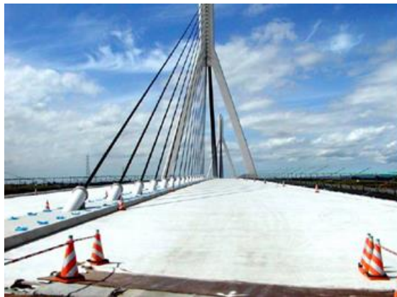
Figura 6 - Tabuleiro da ponte Mihara, em Hokkaido, utilizando-se aço e SHCC (LI, 2004).
