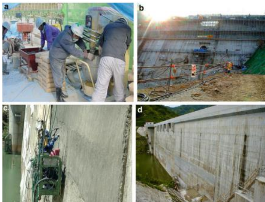
Figura 8 - (a) Preparo do SHCC no local (b) Preparação da superfície da barragem (c) Aplicação do SHCC pulverizado e (d) barragem após reparo (LI, 2019).
