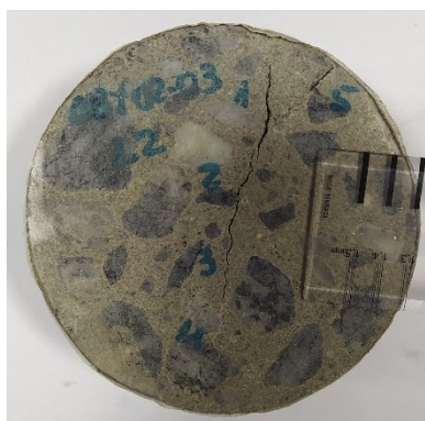
e) L2 – 30 dias após a fissuração
