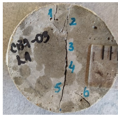
b) L1 – 30 dias após a fissuração
