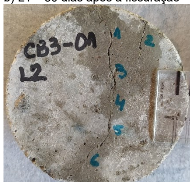
e) L2 – 30 dias após a fissuração
