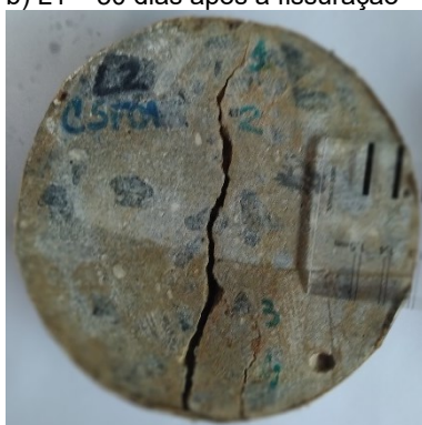
e) L2 – 30 dias após a fissuração
