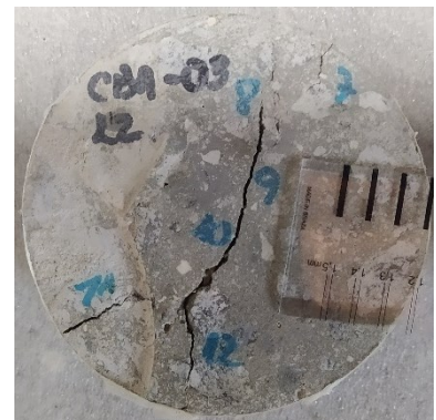
f) L2 – 60 dias após a fissuração
