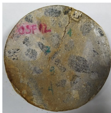
b) L1 – 30 dias após a fissuração
