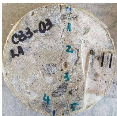
b) L1 – 30 dias após a fissuração
