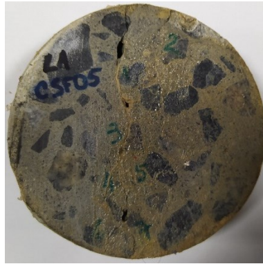
b) L1 – 30 dias após a fissuração
