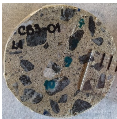
b) L1 – 30 dias após a fissuração
