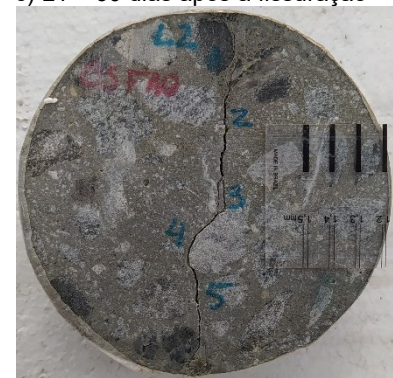
f) L2 – 60 dias após a fissuração
