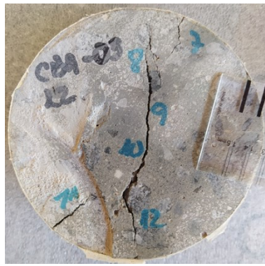
e) L2 – 30 dias após a fissuração
