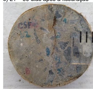
f) L2 – 60 dias após a fissuração
