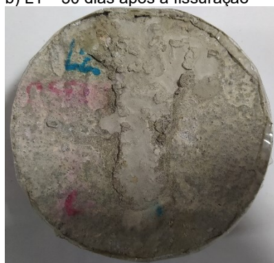
e) L2 – 30 dias após a fissuração
