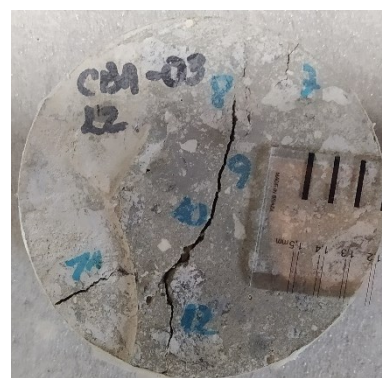
f) L2 – 60 dias após a fissuração
