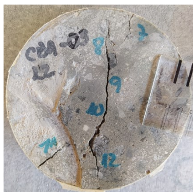
e) L2 – 30 dias após a fissuração
