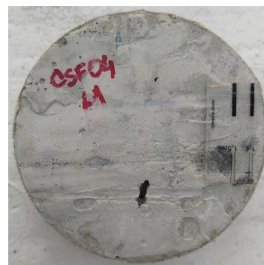
c) L1 – 60 dias após a fissuração
