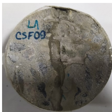
b) L1 – 30 dias após a fissuração
