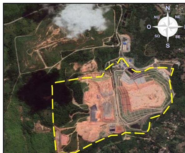
Figura 36 - Fase inicial da operação na Célula II (GOOGLE EARTH, 2015).
