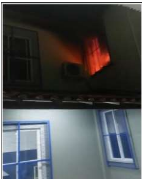
Figura 38 – Incêndio no CAPS
