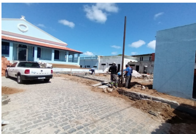
Figura 3 - Escola Abrigo dos Povos em (re)construção
