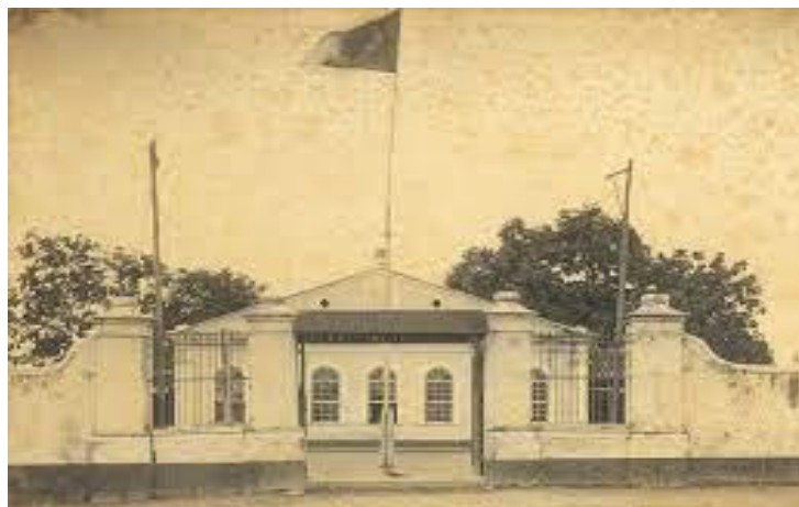
Figura 2 - Escola Abrigo Filhos do Povo
