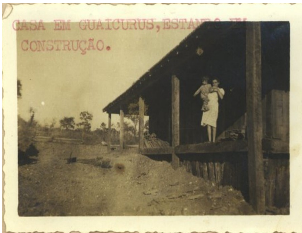
Figura 19: “Casa em Guaicurus, estando em Construção.” (possivelmente tirada em 27/07/1942)
