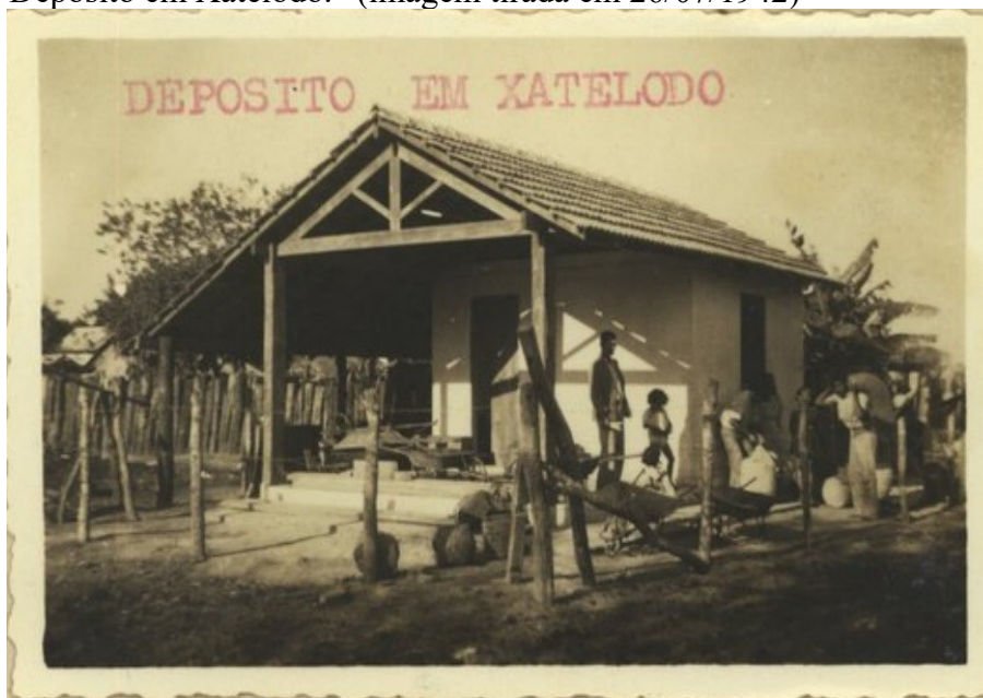
Figura 42: “Deposito em Xatelodo.” (imagem tirada em 26/07/1942)
