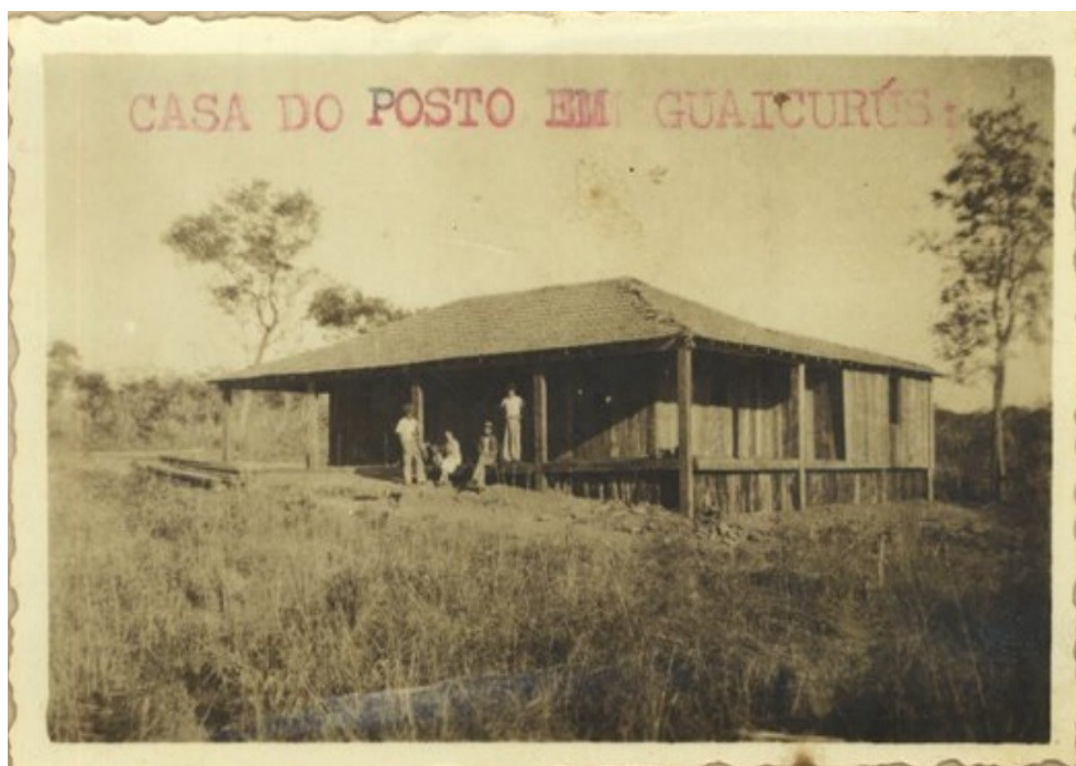
Figura 20: “Casa do posto em Guaicurús” (possivelmente tirada em 27/07/1942)
