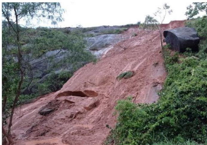
Deslizamento de terra na ES 257. (Defesa Civil)
