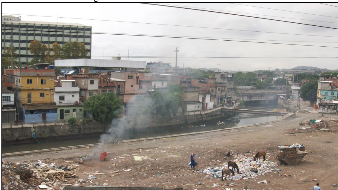
Figura 19 - Beira-Rio antes das obras do PAC – 2009
