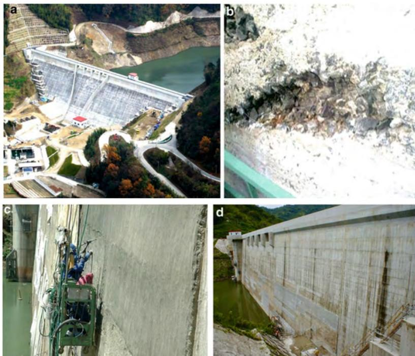
Figura 28 – (a) Barragem de Mitaka, (b) abrasão no talude de montante (c) aplicação de ECC por pulverização e (d) barragem após reparo. (Fonte Li, 2019).
