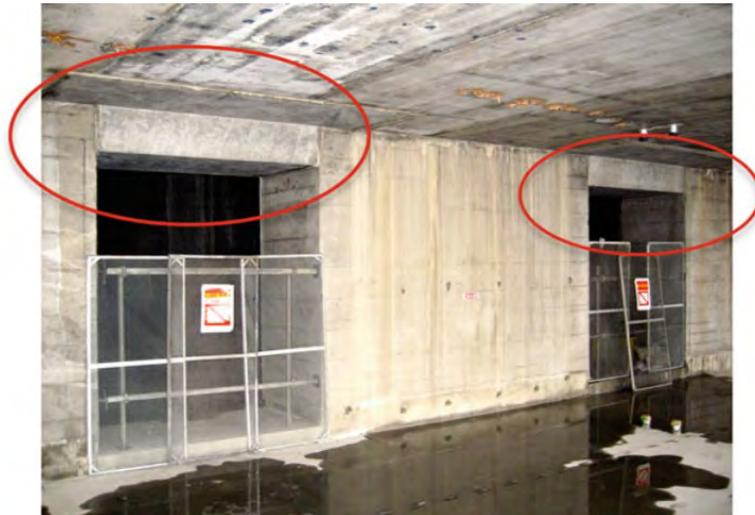
Figura 21 – Vigas de acoplamento localizadas no topo das aberturas ao poço do elevador (Fonte: Li, 2019).
