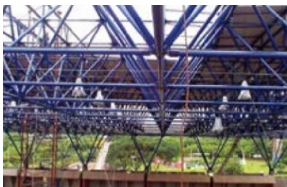
c) Cobertura em universidade (SP)
