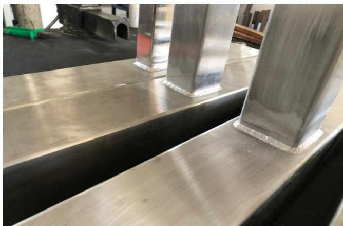
Figura 36 – Limpeza das marcas de solda
