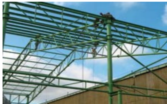
b) Galpão em Belo Horizonte (MG)
