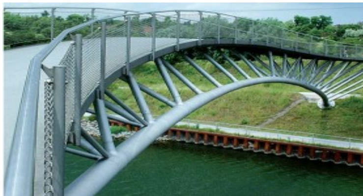
Figura 4 – Ripshorster Bridge (Alemanha), feita com perfis CHS [13]
