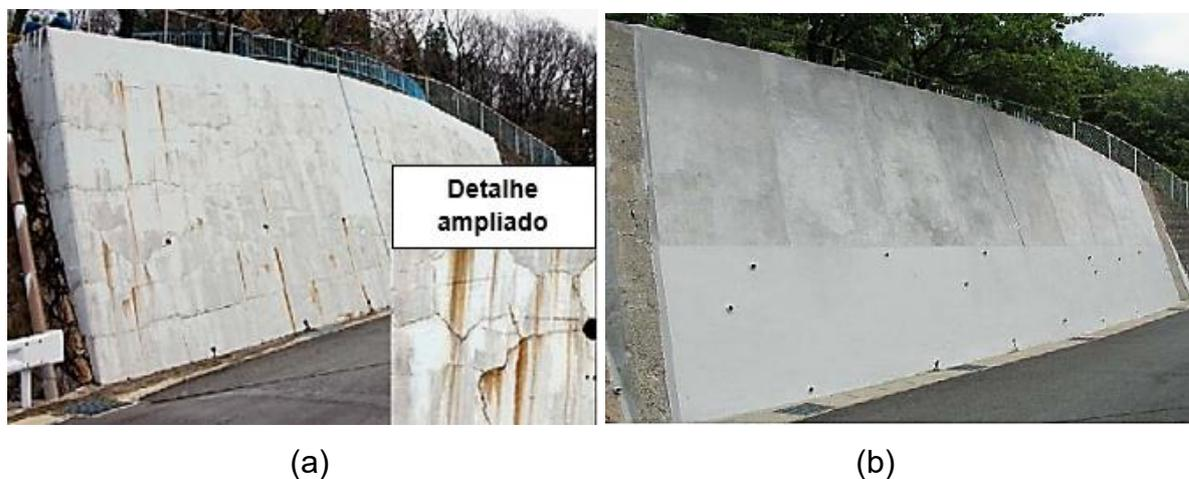
Figura 17 – Muro de Contenção localizado na região de Gifu no Japão, (a) antes da aplicação do reparo e (b) logo após a aplicação do reparo (ROKUGO *et al.*, 2005).
