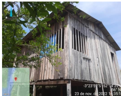
Foto 20 – PR_02_26RI Registro fotográfico de casa ribeirinha fechada e/ou abandonada
