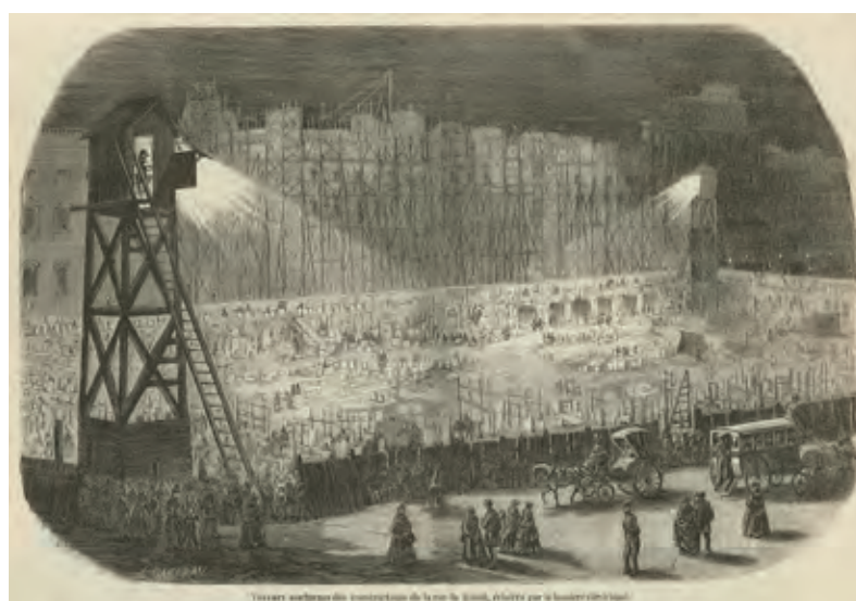
Trabalho noturno nas construções da Rue de Rivoli, iluminadas por luz elétrica, Paris, 1854. Gravura: Jules Galdrau.
