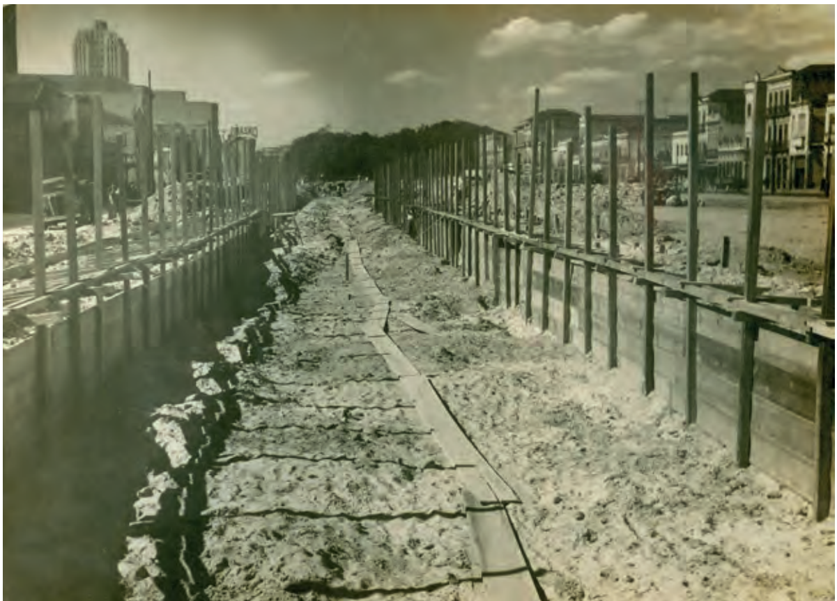
Obras para a abertura da Avenida Presidente Vargas, Centro do Rio de Janeiro, 1942. Fundo Avenida Presidente Vargas, Arquivo Geral da Cidade do Rio de Janeiro.
