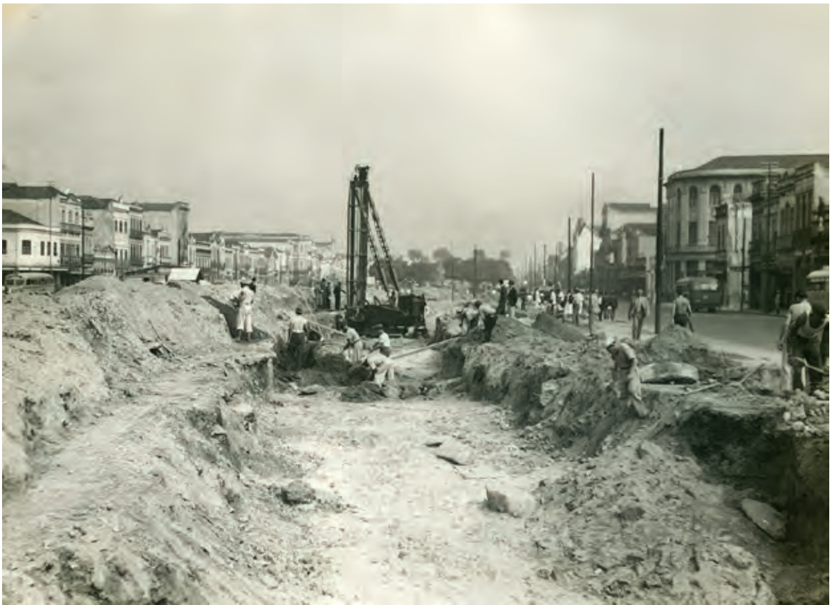
Obras para a abertura da Avenida Presidente Vargas, 1942. Fundo Avenida Presidente Vargas, Arquivo Geral da Cidade do Rio de Janeiro.
