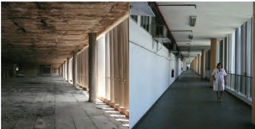
Still do curta-metragem “Homenagem a Matta-Clark” (2015) mostrando a demolição mecânica que separou as duas metades do edifício para que sua parte abandonada pudesse ser implodida, 2010. Foto: Joana Traub Csekő.
