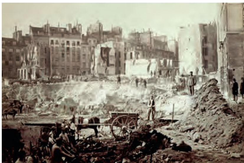
Trabalhos haussmanianos em Paris, s/d, Bibliothèque Nationale de France.
