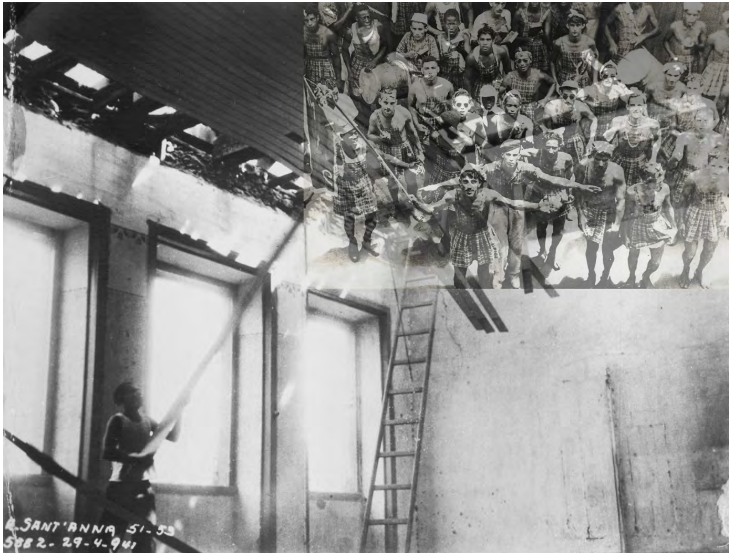
Demolição de prédios da Rua de Santana para abertura da Avenida Presidente Vargas, 1941. Fotógrafo: provável Uriel Malta (Arquivo Geral da Cidade)
