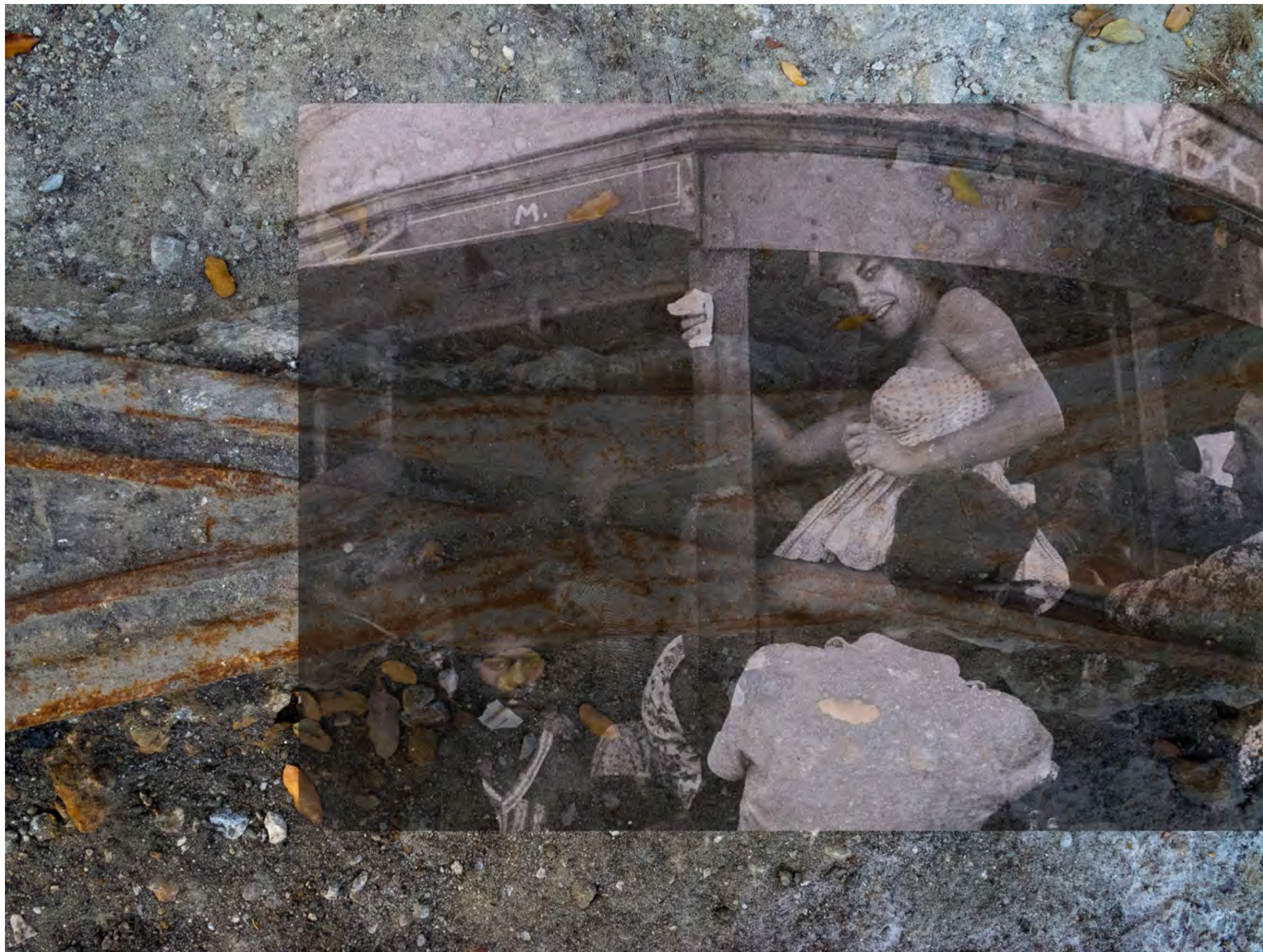
Trilhos de bonde antigos na Praça Tiradentes expostos durante as obras para instalação do Veículo Leve sobre Trilhos (VLT). Centro, Rio de Janeiro, 2015.
