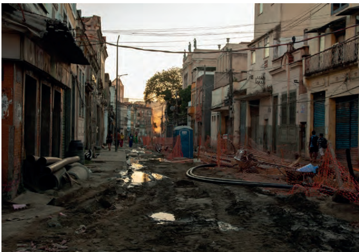
Rua Pedro Ernesto durante as obras para instalação dos trilhos do VLT (Veículo Leve sobre Trilhos), Gamboa, Rio de Janeiro 2016. Foto: Joana Traub Csekö.
