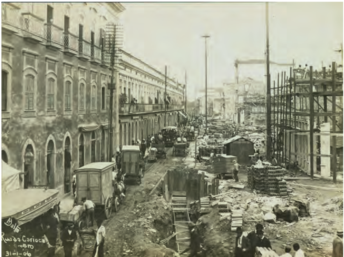
Obras de alargamento da Rua Carioca, Centro do Rio de Janeiro, 1906. Foto: Augusto Malta. Biblioteca Nacional.
