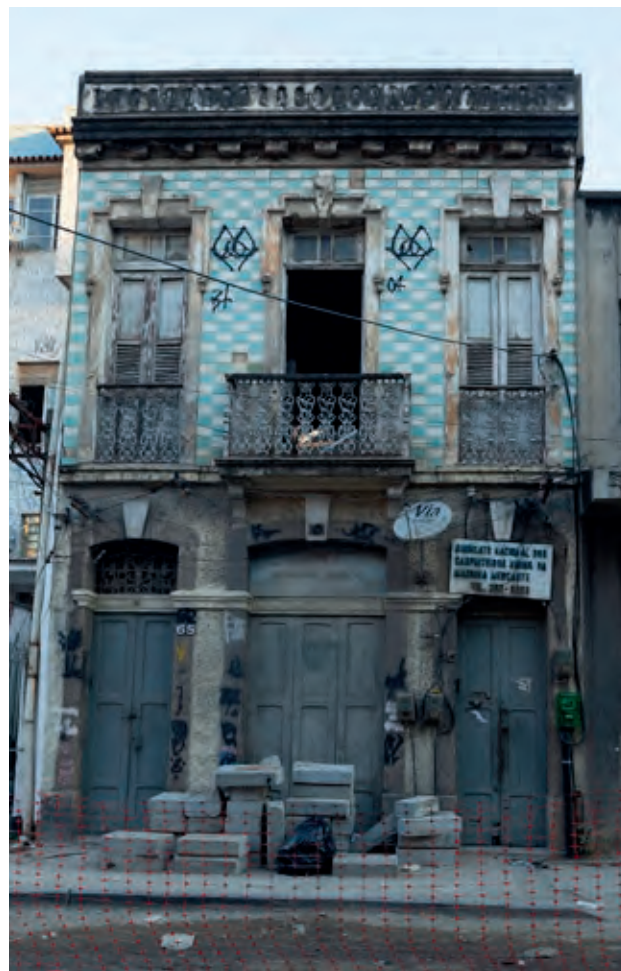
Casa na Rua Pedro Ernesto durante as obras para instalação do VLT, Gamboa, Rio de Janeiro, 2016. Foto: Joana Traub Csekö.
