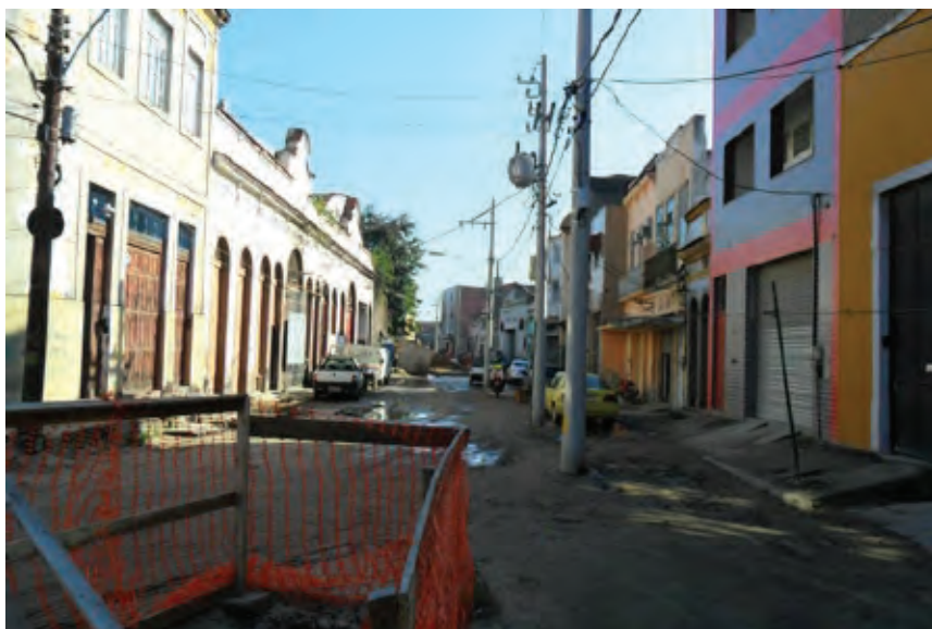
Rua em obras para instalação do VLT (Veículo Leve sobre Trilhos), Gamboa, Rio de Janeiro, 2013. Acervo Kimura Varella.
